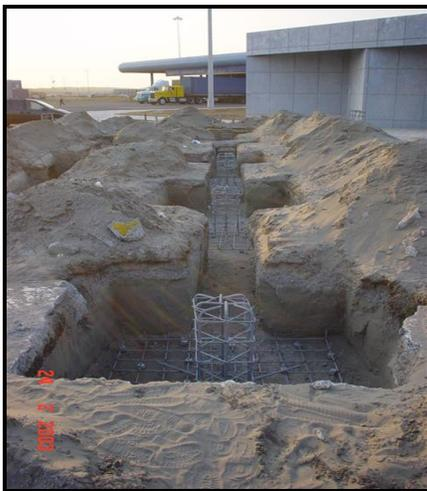
Figura 25 Zapatas Aisladas
