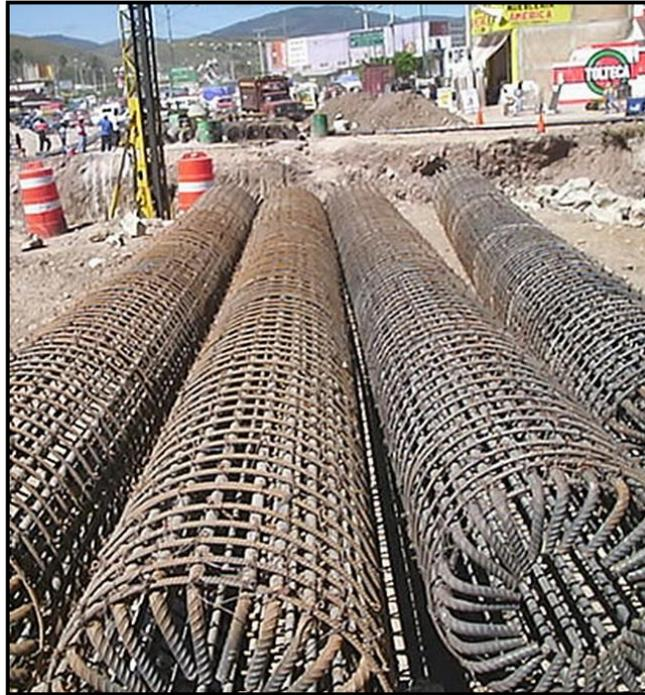
**Figura 27 Pilas (Armado y colado de pilas í in situî )**
