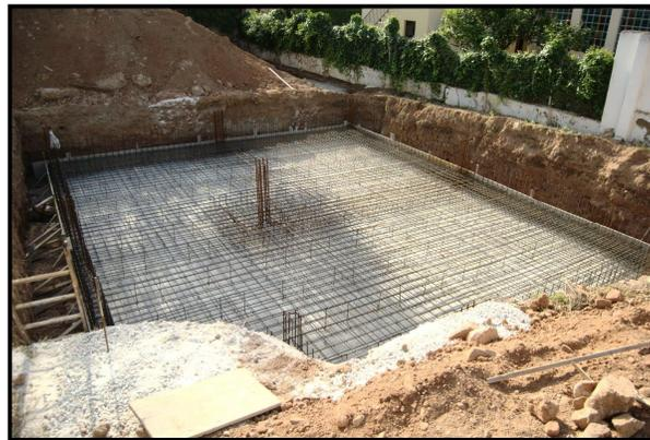
Figura 26 Losa de Cimentación
