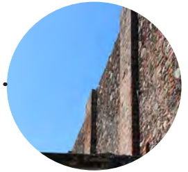
Muro de la ex-hacienda
