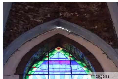
Desprendimiento de muro lateral
