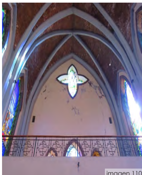
Grietas en muro de la fachada principal
