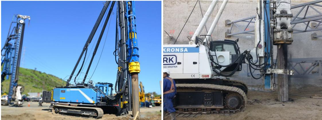
Figura I.6 Hincado de pilotes mediante impacto y vibrado
