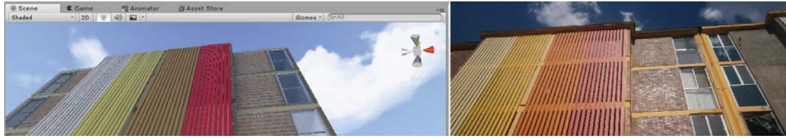
Figura 4.16: Fachada del edificio.
