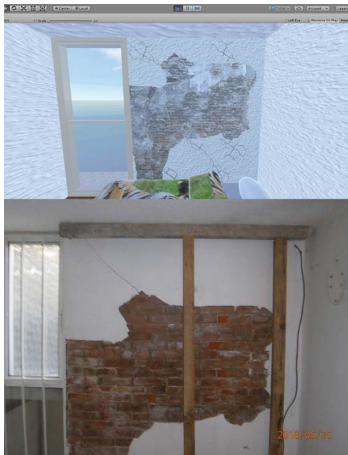
Figura 4.17: Muro de recámara principal.
