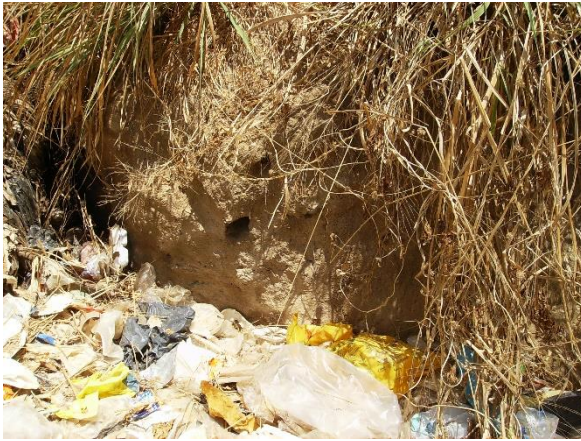
a) Condiciones en el punto SC 1 .
