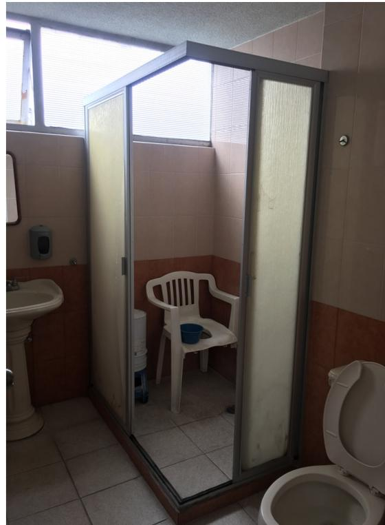
Imagen 24 y 25. Barreras arquitectónicas en los sanitarios, sardineles y muros dividiendo espacios. YNSC.
