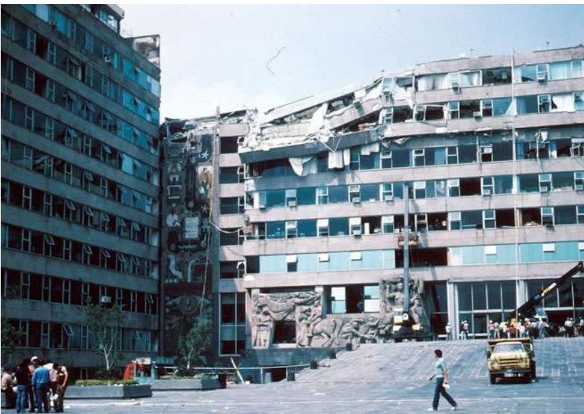
Imagen 2.05. Sismo del 19 de septiembre de 1985, ciudad de México. Edificio de la Secretaría de Comunicaciones y Transportes.
