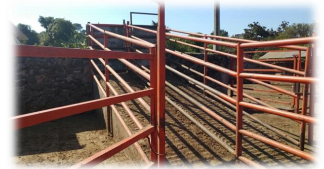
Vista de los corrales del rastro, hechos de perfiles metálicos.
