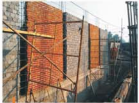
SEMANA 7 Muros perimetrales
