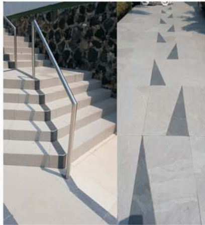
cambio de piso y barandales
