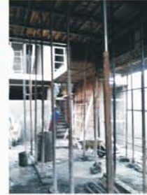
SEMANA 18 Cimbra losa 5
