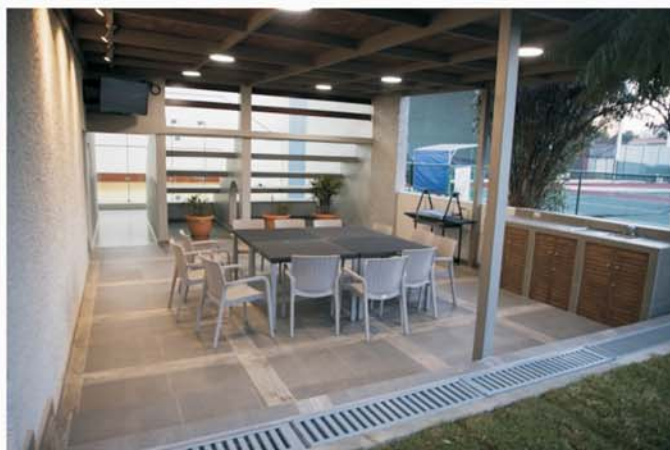
TERRAZA SQUASH construcción
