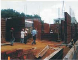
SEMANA 8 Muros Interiores
