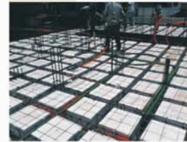
SEMANA 10 Colado LOSA 1
