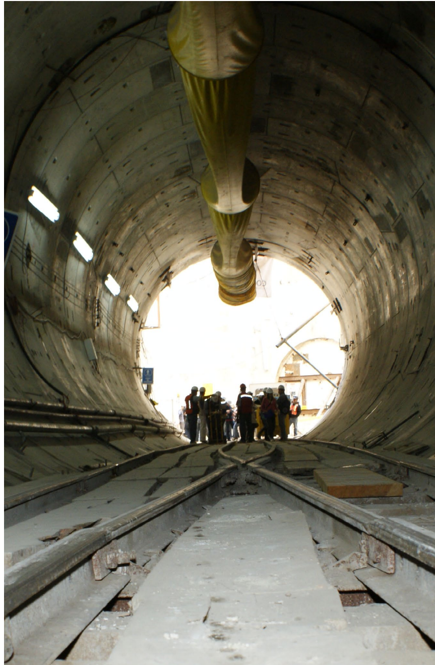
1.10 Túnel Emisor Oriente en 2011
