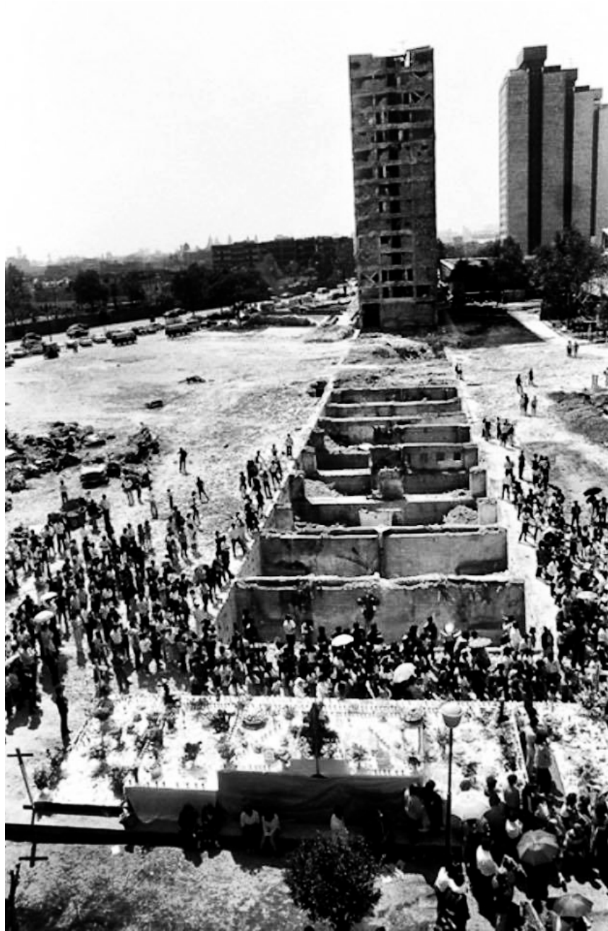
2.29 Edificio Nuevo León tras el sismo de 1985
