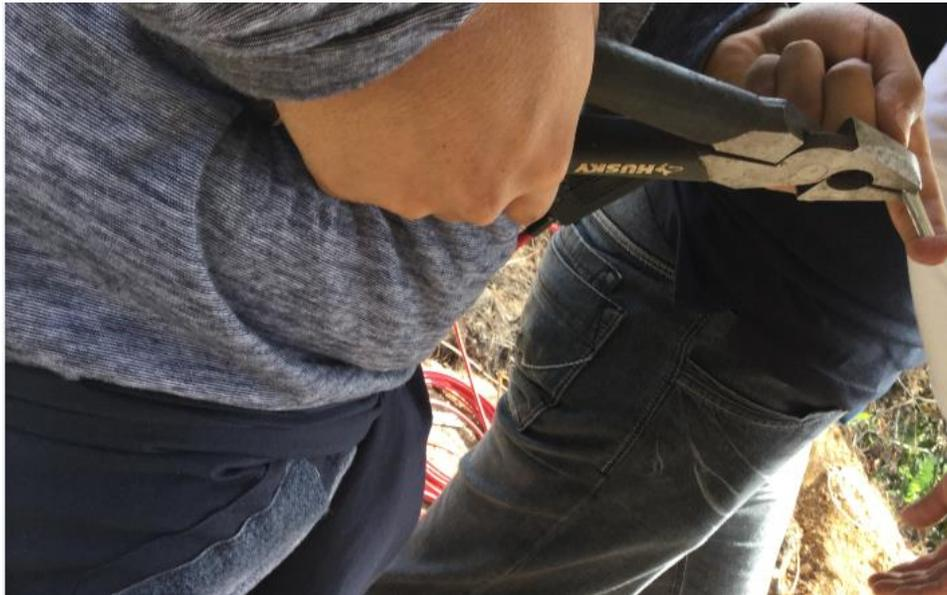
Figura 73. Comprimiendo la terminal para el cable.
