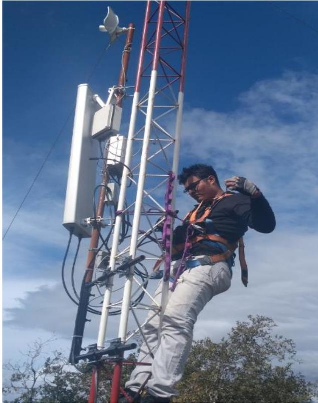
Figura 81. Montaje de la antena sectorial
