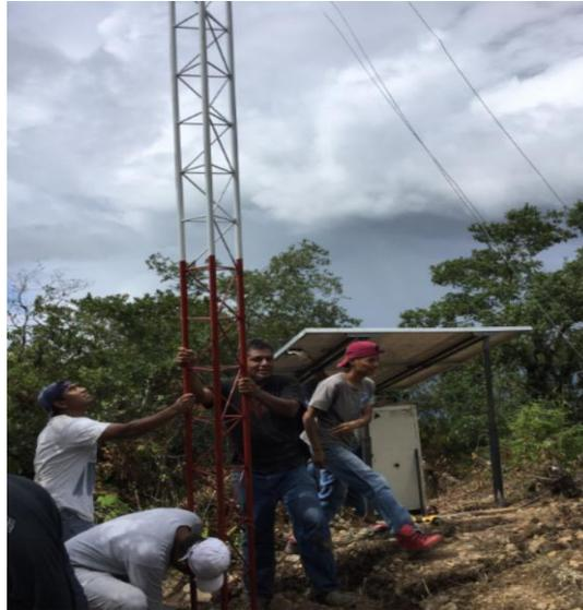
Figura 70. Colocación de la Torre.
