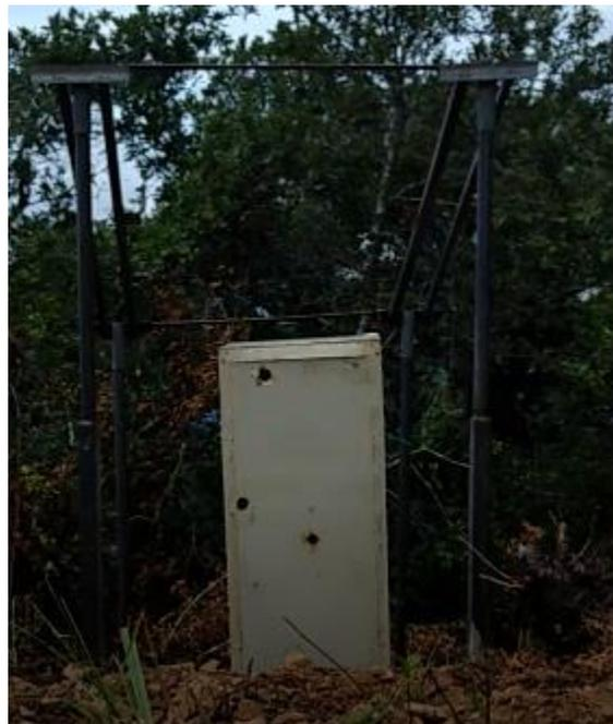
Figura 71. Montaje especial para las celdas y armario para colocar las baterías de ciclo profundo.
