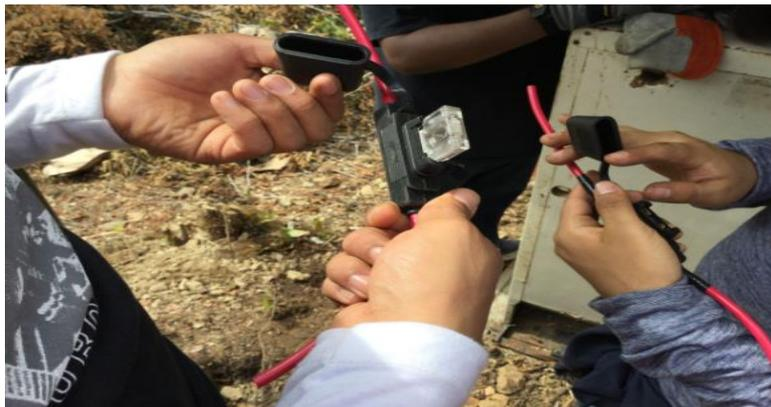
Figura 75. Fusibles para protección del conector MC-4.
