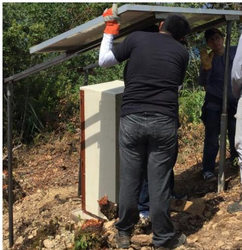
Figura 68. Paneles fotovoltaicos y estructura para sostener los paneles fotovoltaicos.
