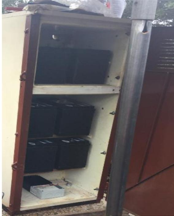
Figura 78. Colocación del regulador de carga y baterías en el refrigerador.
