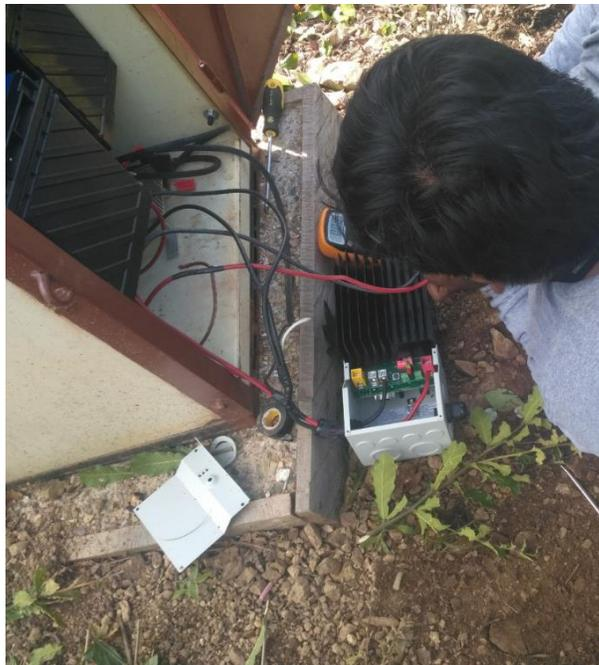
Figura 80. Configuración del regulador de carga.
