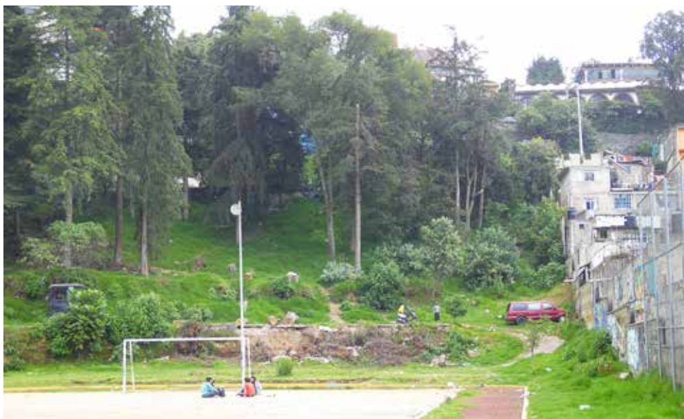
Foto 14. Vista de la pendiente de sur a norte
