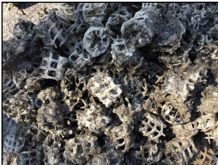
Figura 5.10. Estado de empaques de columna de desorción 3 meses después de inicio de operación.
