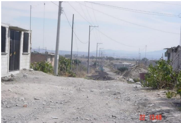
Red eléctrica para tomas domiciliarias en Real de España y Los Arroyitos
