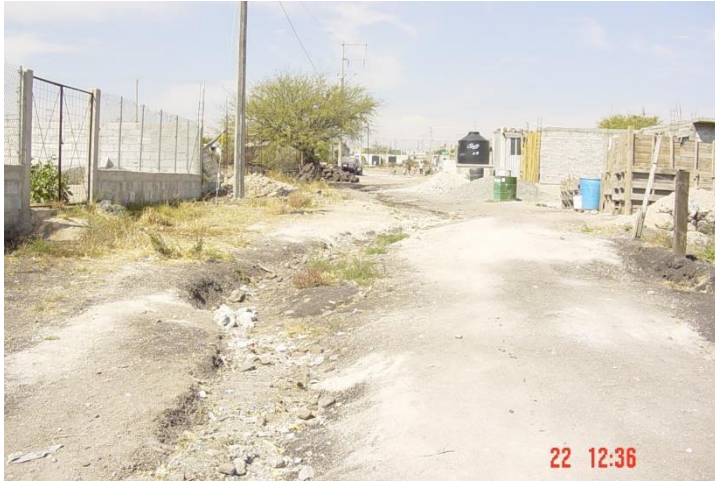
Hidrantes en Los Arroyitos
