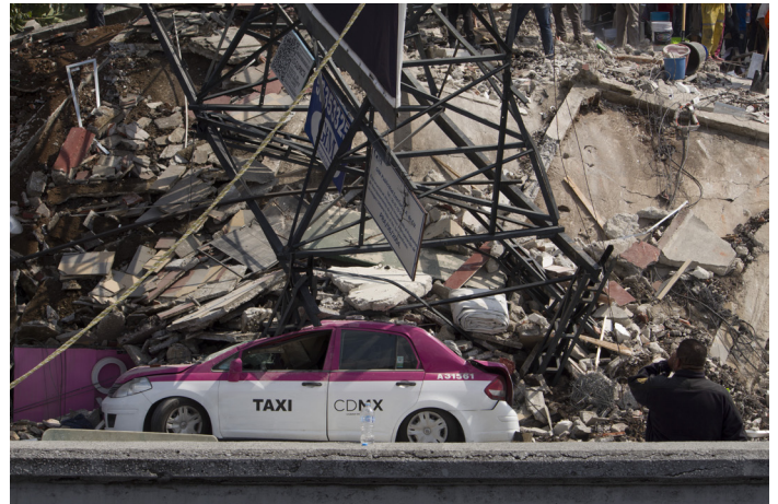
Edificio de viviendas colapsado durante sismo 19-sep-17.
