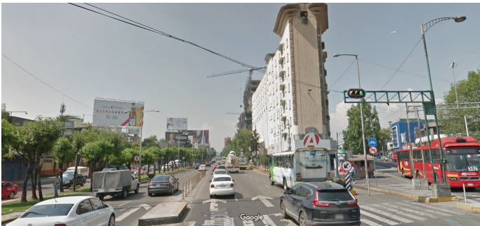
Edificio Ermita. Juan Segura. Fuente: Google Maps
