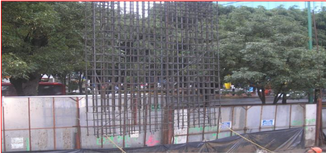
Figura 109. Colocación del armado de muro Milán; Autor: Ing. Francisco Israel Callejas Quezada. (CIMESA 2011).
