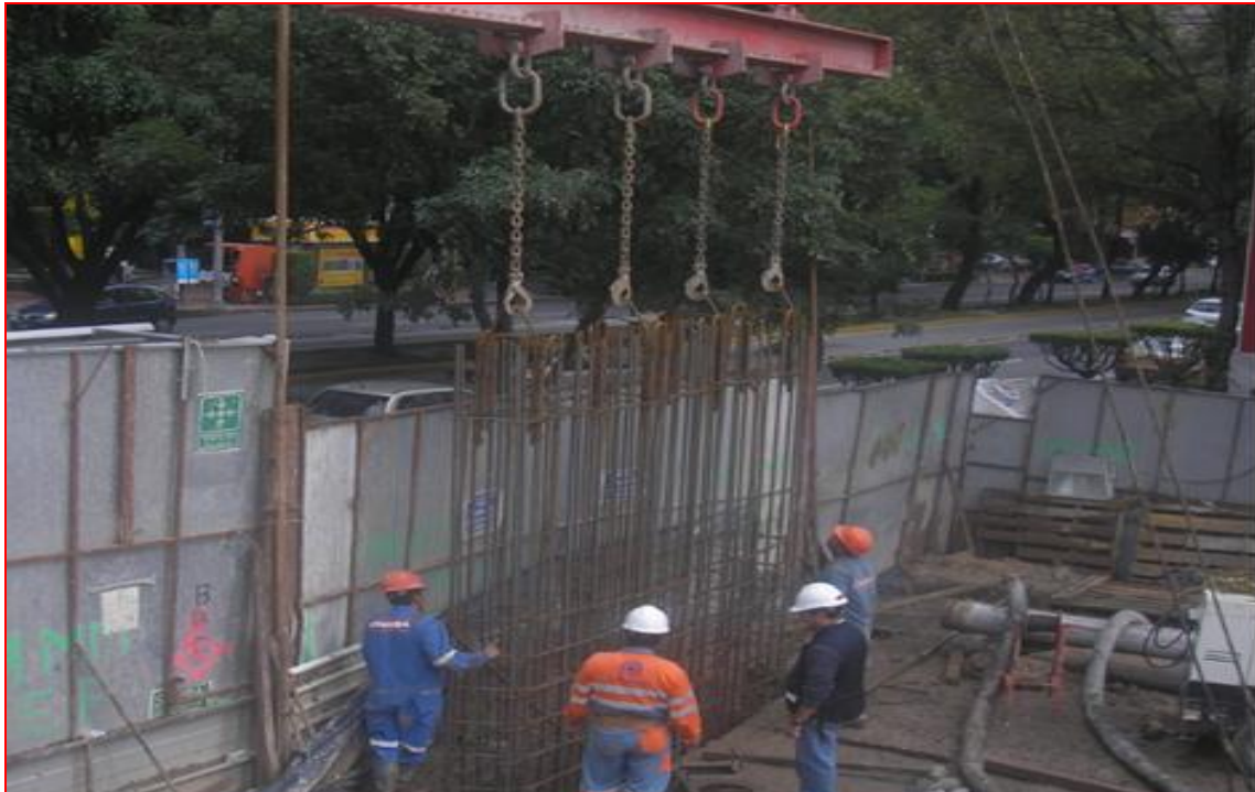
Figura 114. Introducción del armado de muro Milán dentro de la lumbra; Autor: Ing. Francisco Israel Callejas Quezada. (CIMESA 2011).
