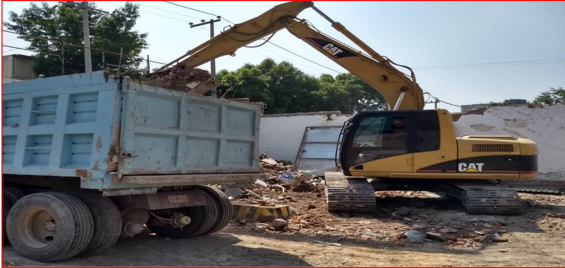
Figura 54. Excavadora CAT 312 realizando maniobras de movimiento de tierras; proyecto "MARHNOS, Lago Filt 7". (CIMESA 2018).
