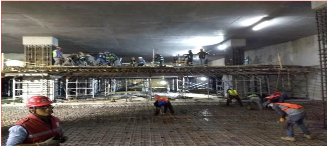
Figura 16. Ejecución de proyecto "MIRA, Río San Joaquín 498" con método Top-Down. (CIMESA, 2018).
