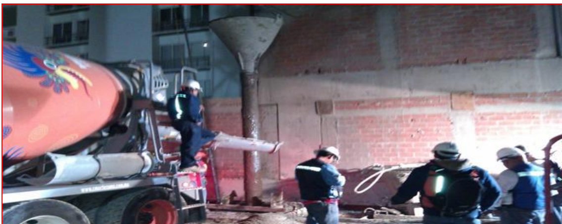
Figura 123. Corte de tubería en colado de panel de muro Milán; Autor: Ing. Francisco Israel Callejas Quezada. (CIMESA 2011).
