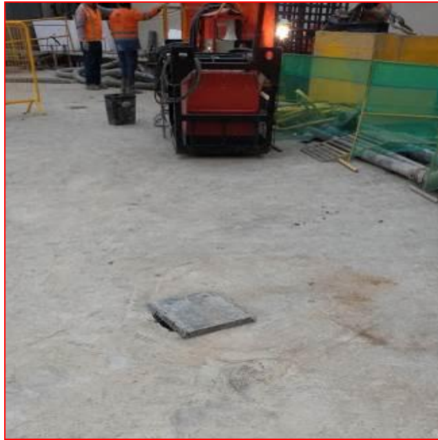
Figura 128. Pozo de abatimiento del nivel freático en el sitio de obra. (CIMESA 2019).
