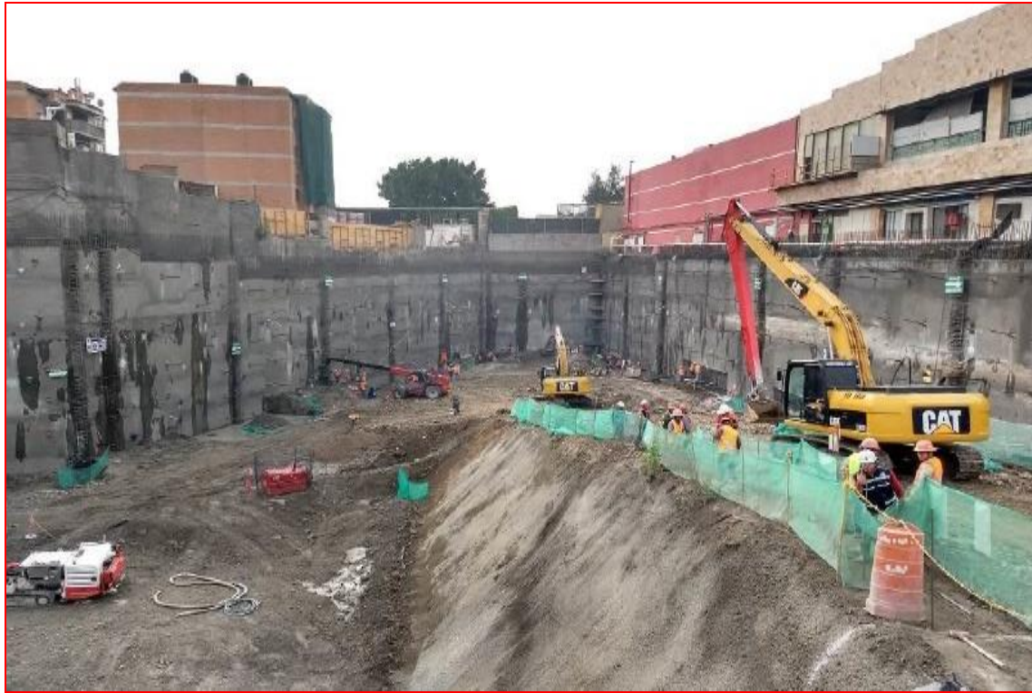
Figura 18. Excavación a cielo abierto estabilizada con anclas. Proyecto "ATANA, Lindavista". (CIMESA, 2018).
