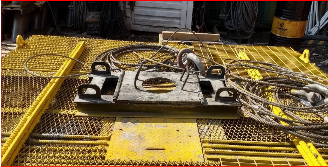
Figura 61. Presentación en obra de trampa para Tubería Tremie; proyecto "MARHNOS, Lago Filt 7". (CIMESA 2018).
