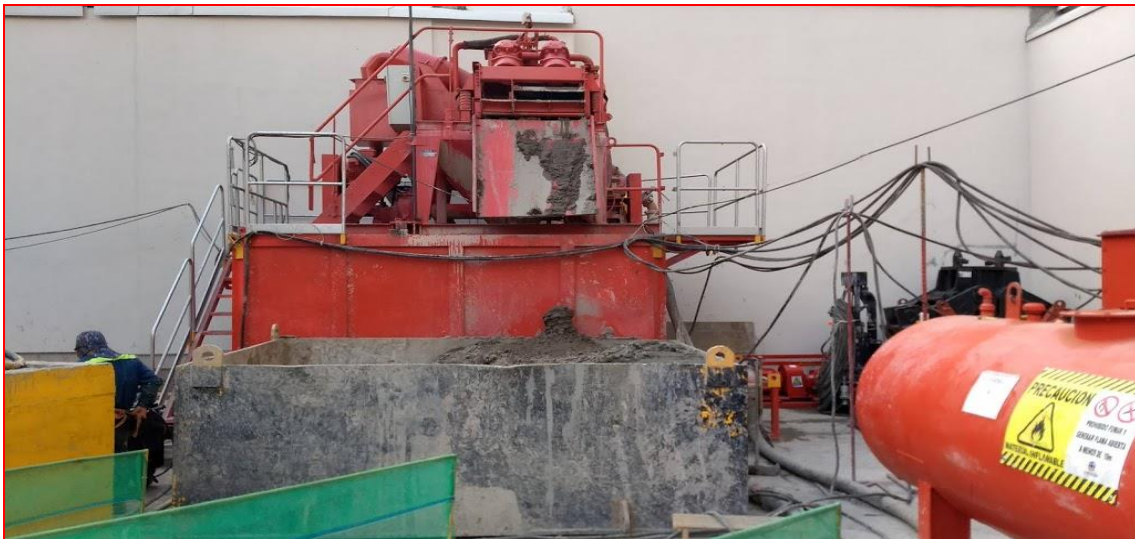
Figura 69. Desarenador tipo Caviem y artesa para desecho de rezaga. (CIMESA 2019).
