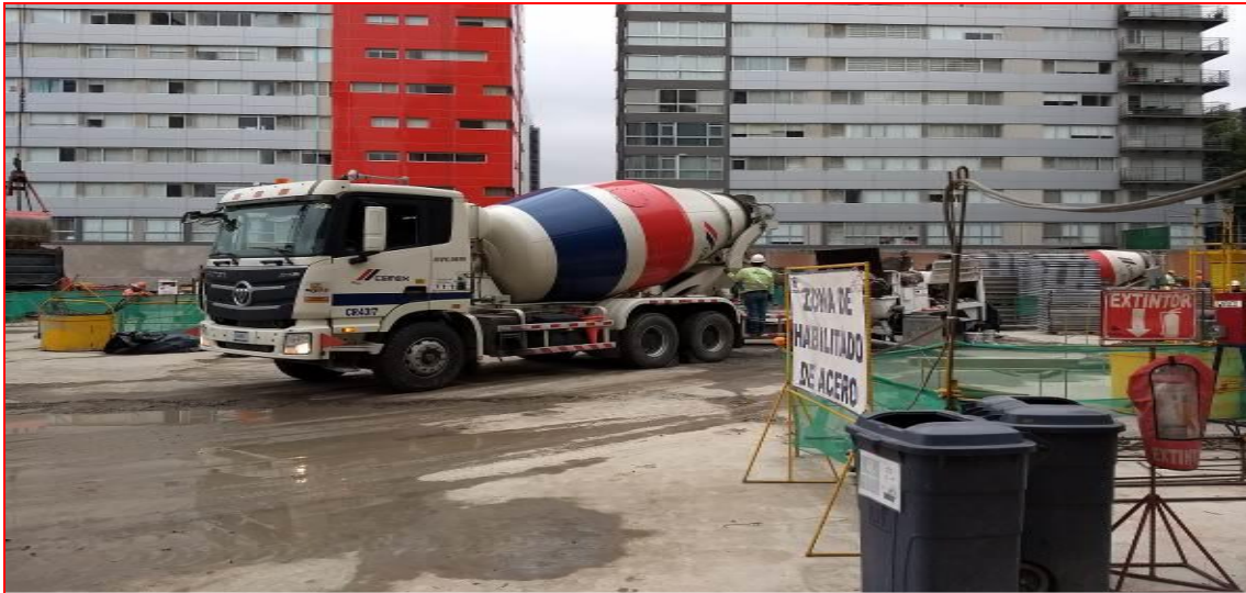
Figura 56. Olla de concreto durante la realización de un colado; proyecto "MIRA, Río San Joaquín 498". (CIMESA 2018).
