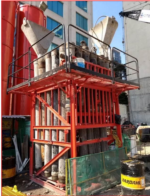
Figura 117. Rack de tubería tremie; proyecto "MARNHOS, Lago Filt 7". (CIMESA 2018).
