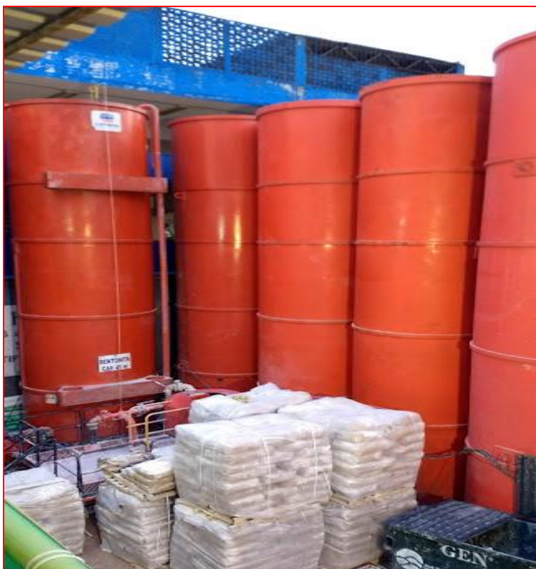
Figura 75. Vista parcial de la central de lodos en el predio de interés. (CIMESA 2019).
