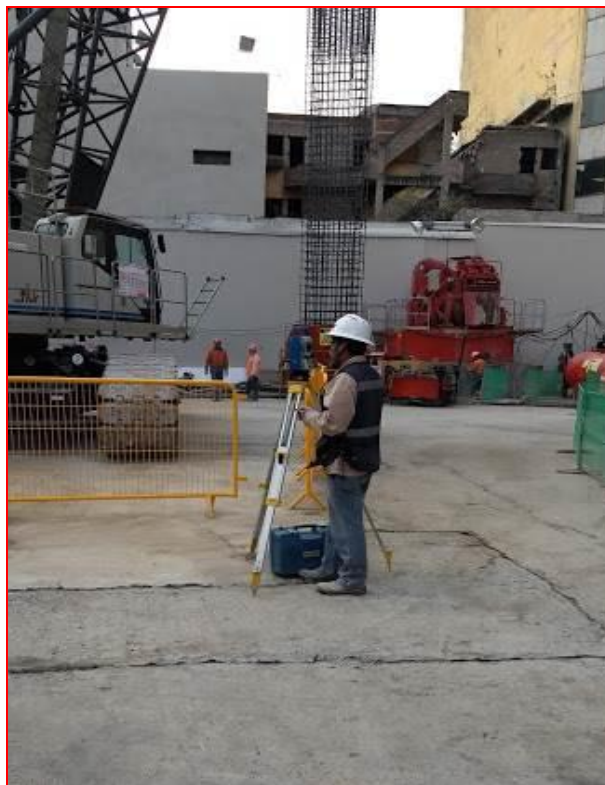
Figura 71. Estación total y brigada de topografía en el sitio de proyecto. (CIMESA 2019).
