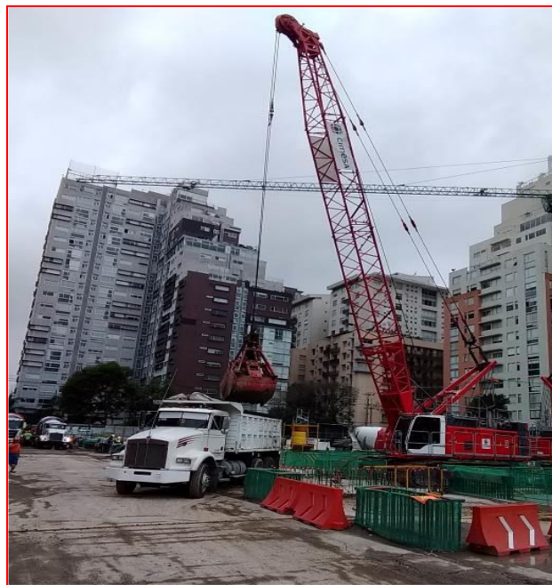
Figura 57. Camión torton; proyecto "MIRA, Río San Joaquín 498". (CIMESA 2018).
