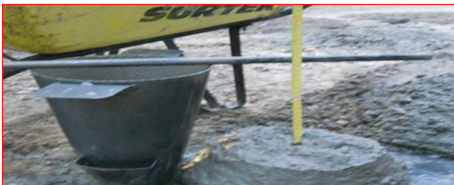
Figura 126. Prueba de revenimiento previa a colado de muro Milán; Autor: Ing. Francisco Israel Callejas Quezada. (CIMESA 2011).
