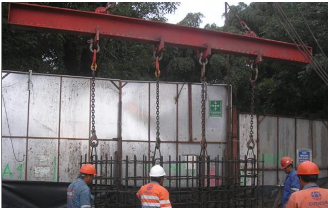
Figura 115. Introducción del armado de muro Milán dentro de la lumbra; Autor: Ing. Francisco Israel Callejas Quezada. (CIMESA 2011).
