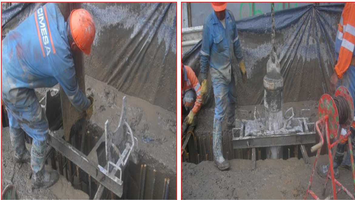
Figura 118 y 119. Colocación de tubería tremie, freno de tubería y sonda para la medición del nivel de concreto, previo al colado; Autor: Ing. Francisco Israel Callejas Quezada. (CIMESA 2011).
