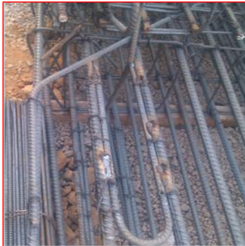
Figura 125. Soldadura en asas de muro Milán; Autor: Ing. Francisco Israel Callejas Quezada. (CIMESA 2011).
