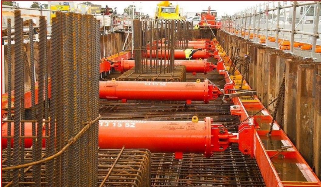
Figura 15. Uso de precarga en excavaciones. (Honvajec, Joseph. 2015).
