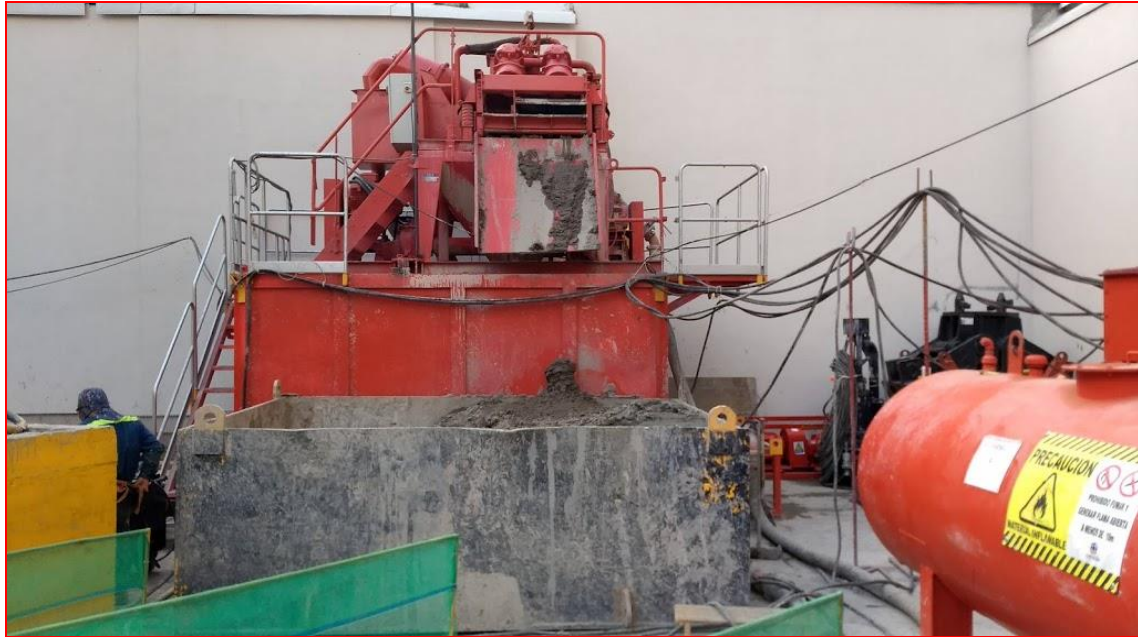
Figura 93. Rezagado del proceso de desarenado de muro Milán. (CIMESA 2019).
