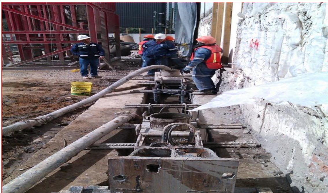
Figura 95. Desarenado de muro Milán; Autor: Ing. Francisco Israel Callejas Quezada. (CIMESA 2011).
