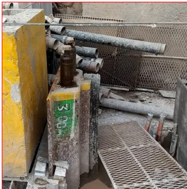
Figura 98. Junta waterstop colocada en la excavación del sitio de obra. (CIMESA 2019).
