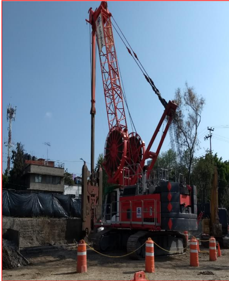
Figura 52. Grúa Liebherr HS 855 equipada con almeja hidráulica, previo a la colocación del armado de muro Milán; proyecto "MARHNOS, Lago Filt 7". (CIMESA 2018).
