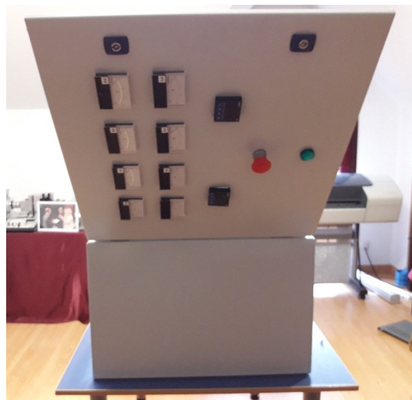
Figura 3.30 Panel del cuadro eléctrico (Puerta abierta).
