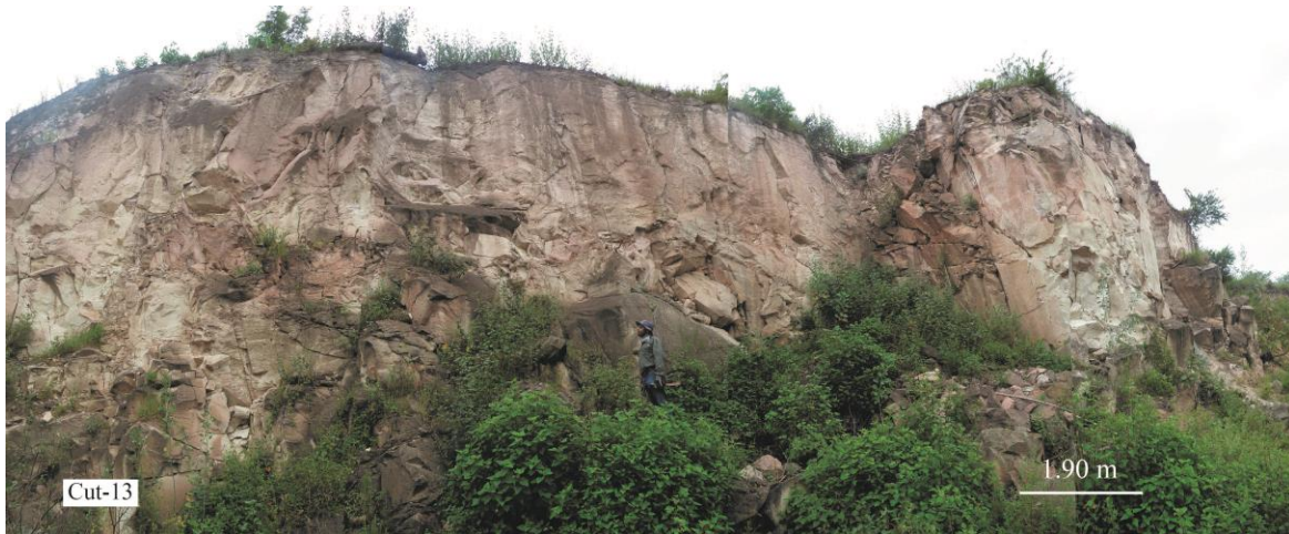
Fig. 26 Estación geológica Cut-13. Roca fracturada con variaciones de color, textura piroclástica, presenta al menos dos tipos de fragmentos de líticos y se observan caídos de rocas.
