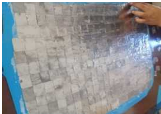
Imagen 64.Colocado de láminas de plomo de forma horizontal.
