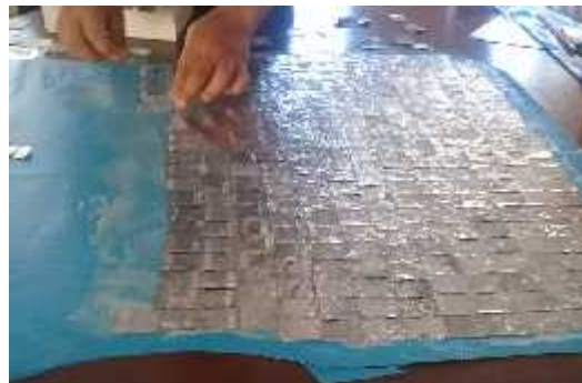
Imagen 62. Colocación de láminas de plomo de forma vertical.
