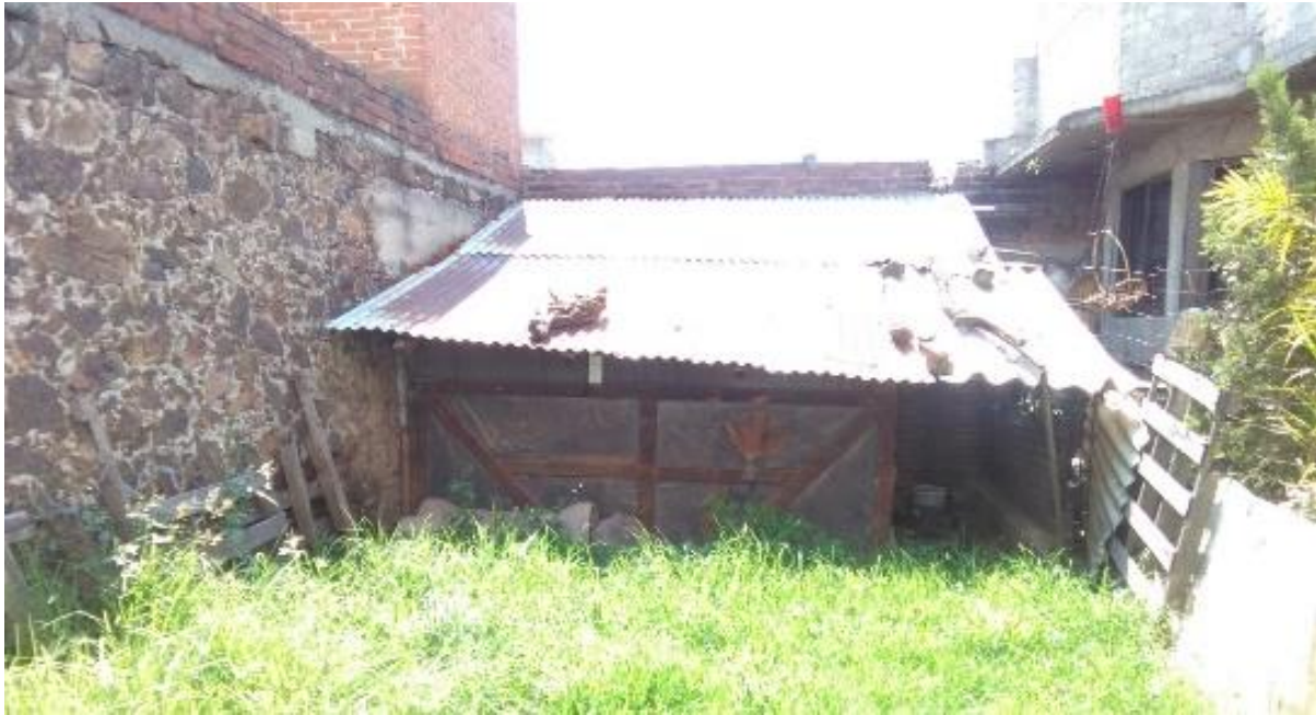
Ilustración 32. Cuarto de Baño
