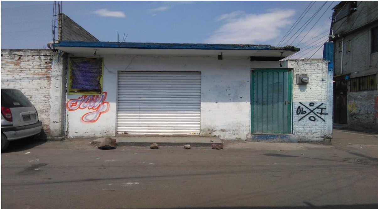
Fotografía de la fachada sobre Av. Insurgentes tomada después del sismo
