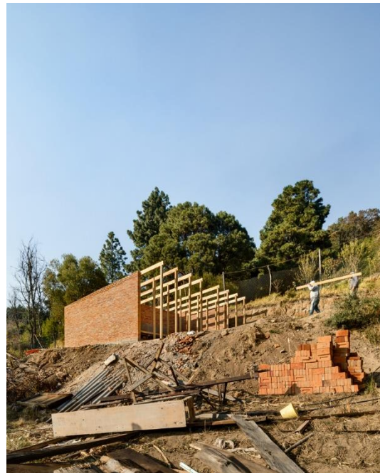
Ilustración 5. "Vivienda en Montaña", Lerma, Estado de México por CC Arquitectos, proceso constructivo comunitario.
