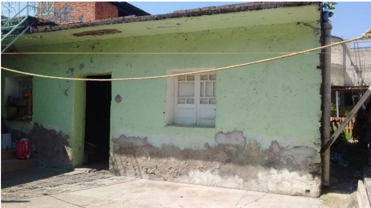
Fachada oriente de la vivienda (ya deshabitada) al interior del predio,
