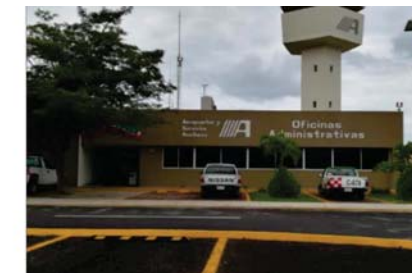
Izquierda: Ilustración 57 Edificio Administrativo Derecha: Ilustración 58 Oficinas DGAC Fuente: Foto proporcionada por ASA
