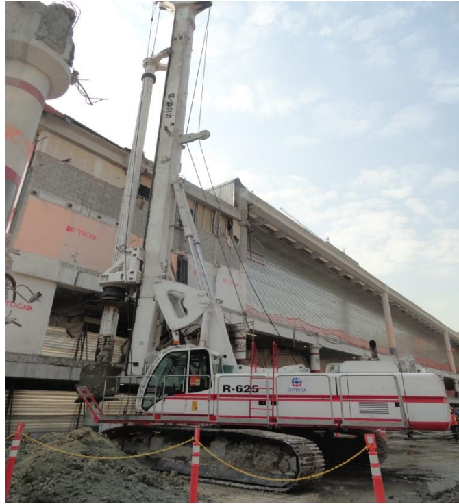
PERFORADORA SOILMEC MODELO R-625
