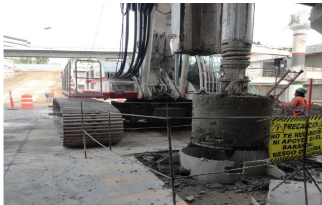
PERFORADORA SOILMEC MODELO R-625, CON BOTE DESAZOLVADOR
