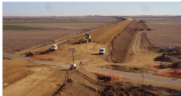
Figura 2.6 – Capa de forma del terraplén , Ilustración, 2014. Recuperado de http://descubriendolaingenieriacivil.blogspot.mx/2014/10/
