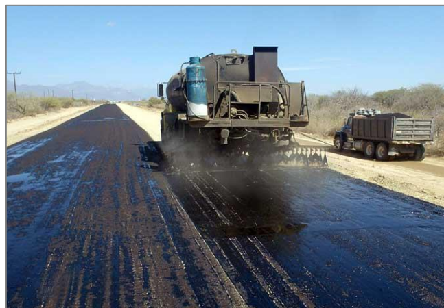
Figura 2.2 – Riego de liga, Ilustración, s.f. Recuperado de http://www.cabonuevoconstrucciones.com/
