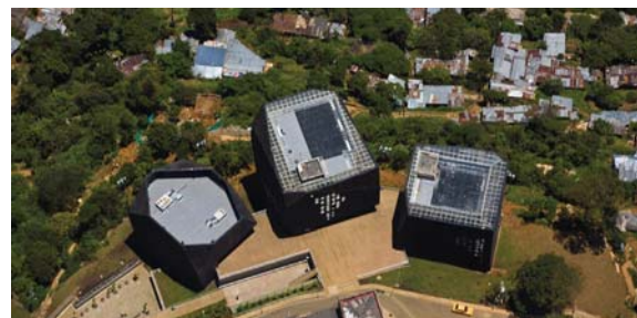
Figura 15. Tobon, C. "Parque Biblioteca España" vista aérea en planta [Fotografía]. Recuperado de https://www.archdaily.mx
