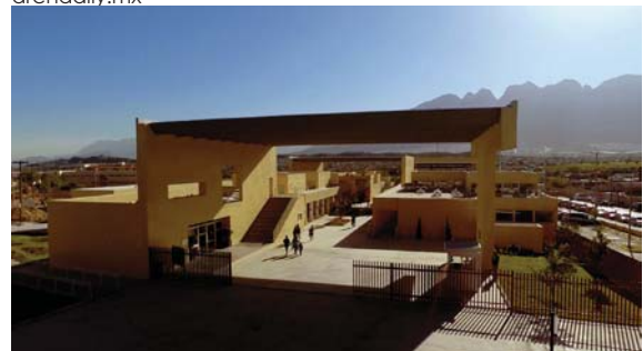
Figura 23. Taboada, J. "Macro Centro Comunitario San Bernabé", acceso principal [Fotografía]. Recuperado de https://www.archdaily.mx
