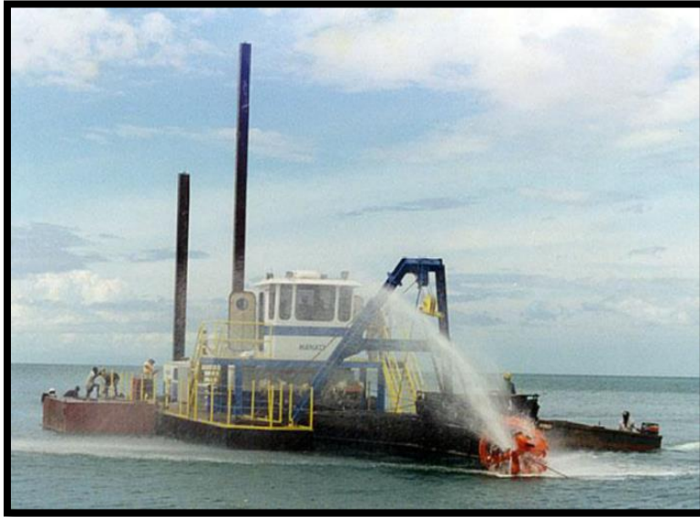
Figura 16. Sistema de extracción y dragado con una draga.
