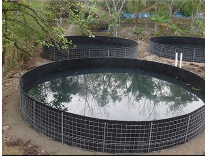
**Figura 29.** Depósito de alambre revestido con geomembrana. Fuente: ATL, 2010.
