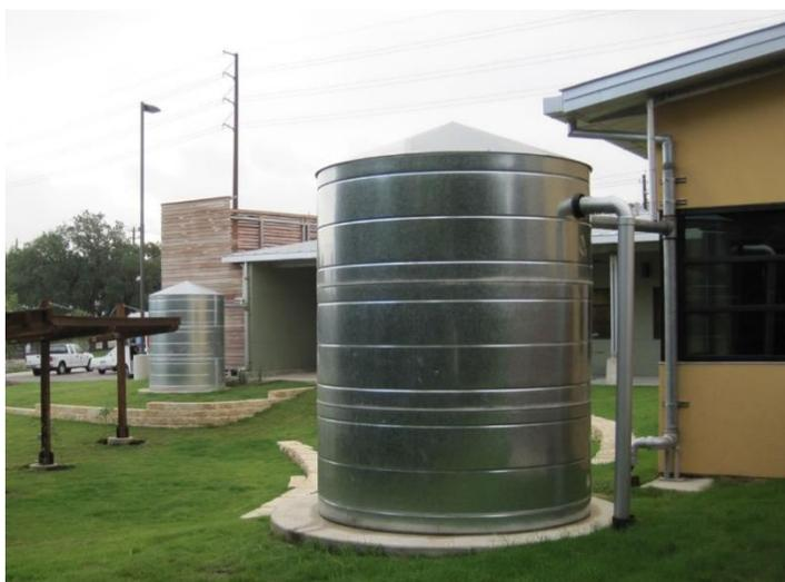
**Figura 28.** Depósito de fierro galvanizado. Fuente: Innovative Water Solutions, 2010.
