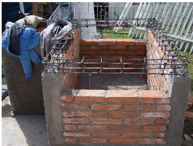
**Figura 27.** Construcción de cisterna de ladrillo. Fuente: Gobierno del Estado de Aguascalientes., 2012
