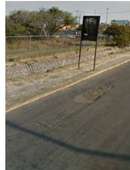
Baches generados por vehículos de tránsito pesado.
