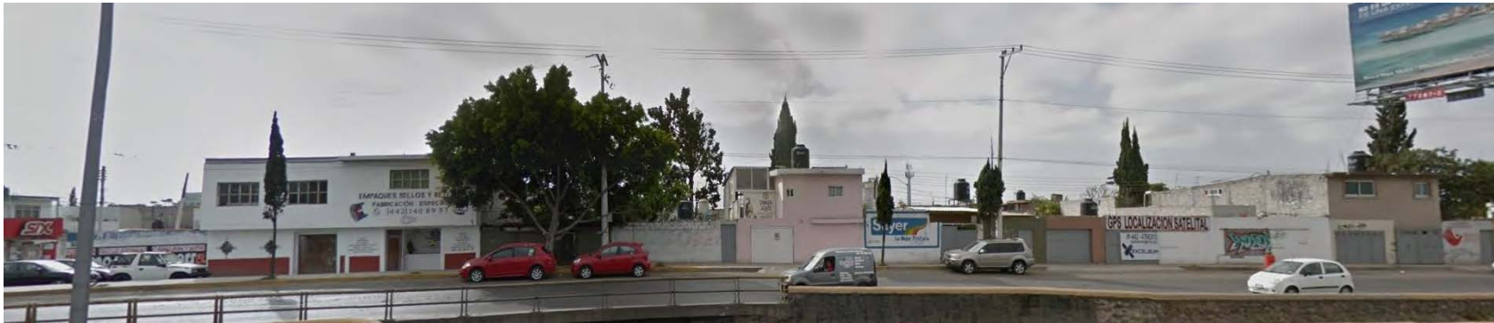
Imagen de fachadas del otro lado del terreno. Captura de imágenes: noviembre, 2017. © 2018 Google México.
