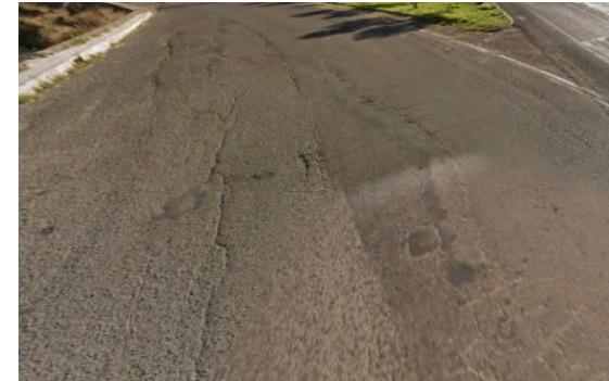
Baches generados por vehículos de tránsito pesado.
