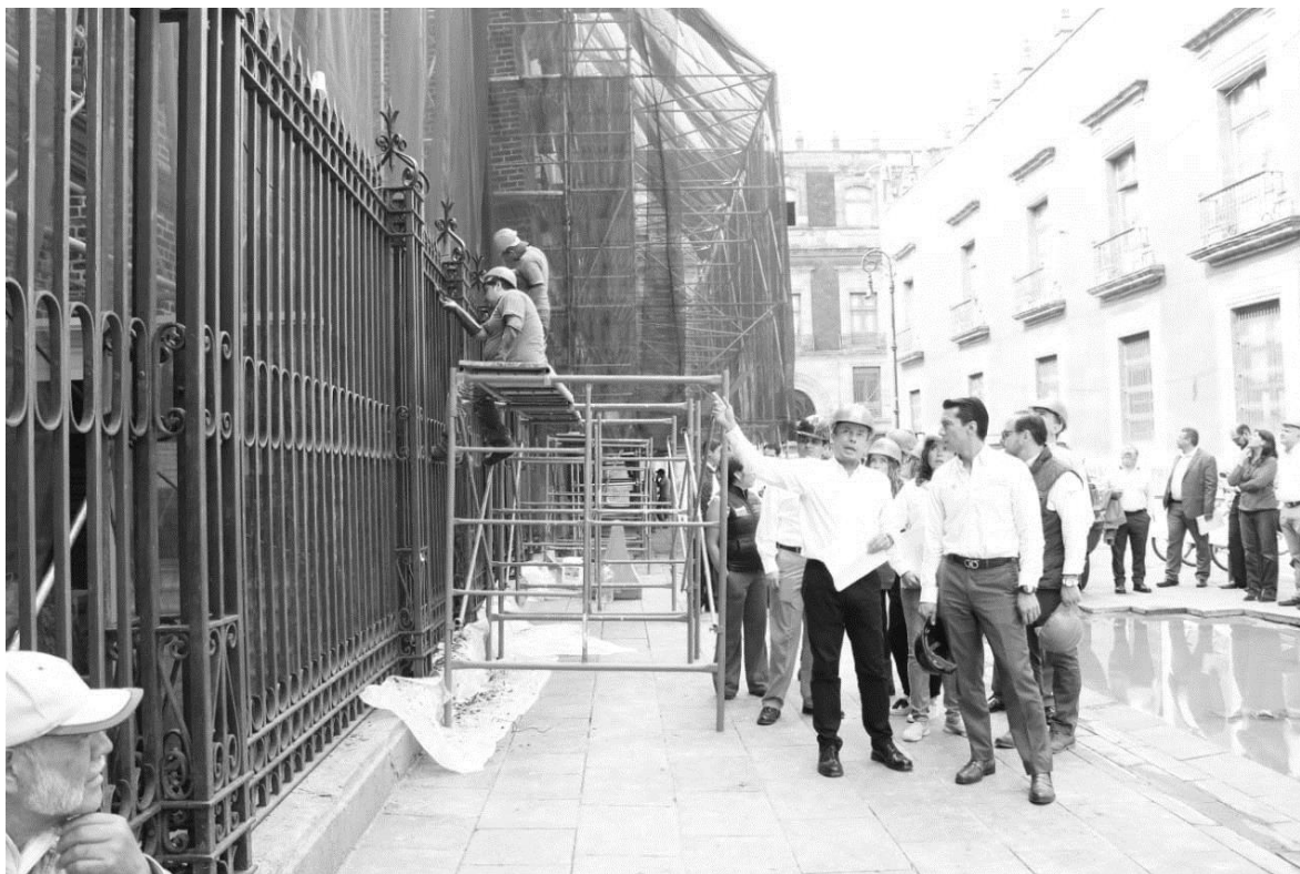
Ilustración 30 Supervisión de obras
