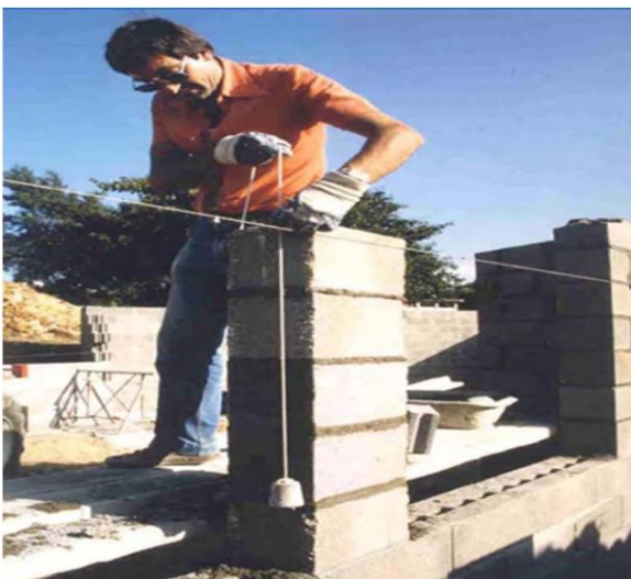
Foto 25, colocación block en muros de acuerdo al secuencial. Fuente: Propia
