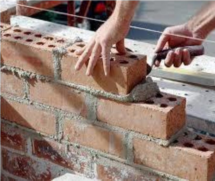
Foto 11, Junteo de Piezas Multiperforadas. Fuente: Propia
