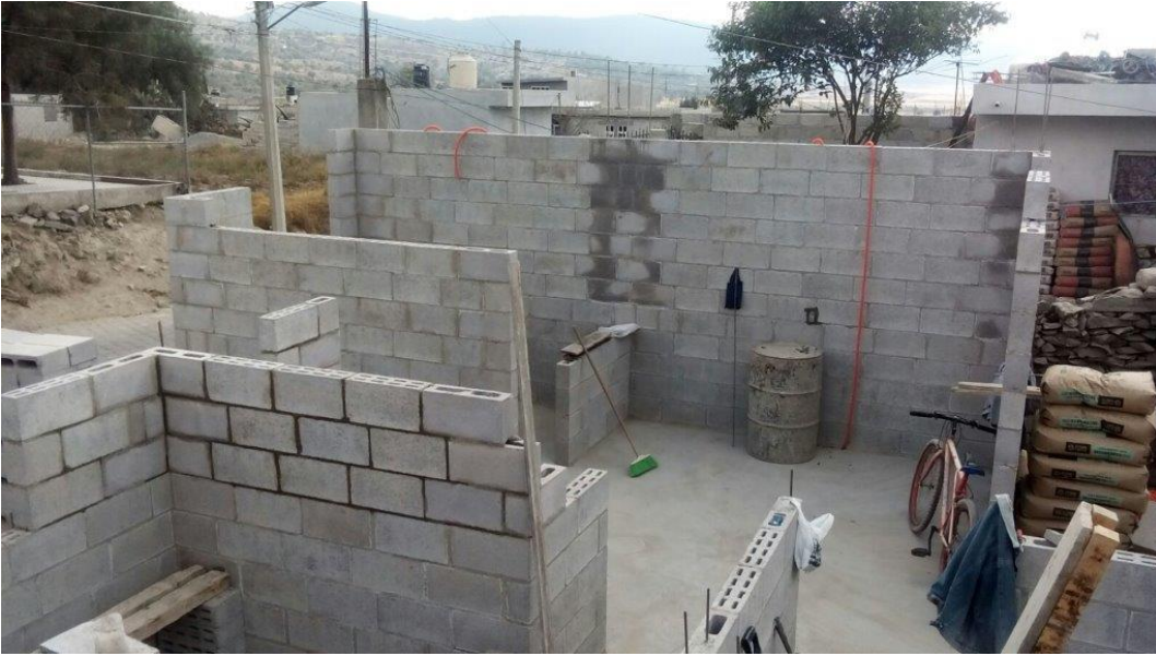
Foto 23, colocación block en muros del proceso constructivo de acuerdo al secuencial. Fuente: Propia
