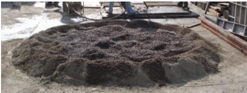
Foto 7, Mezclados por medios manuales
