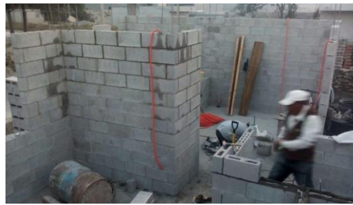
Foto 24, colocación block en muros de acuerdo al secuencial. Fuente: Propia
