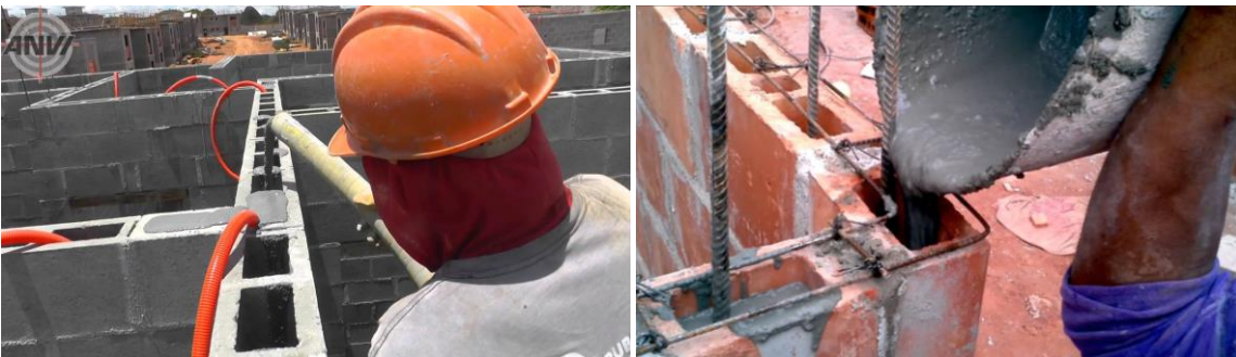
Foto 12, Relleno de Mortero, Fuente: Propia
