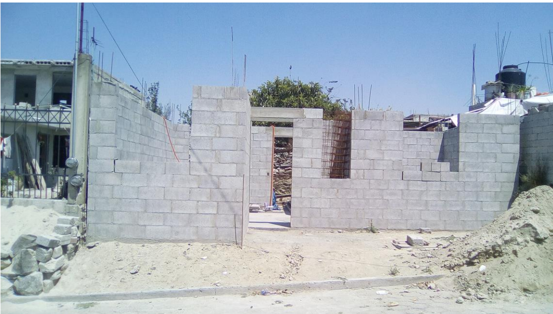
Foto 26, fachada de acuerdo a la modulación de block en muros. Fuente: Propia
