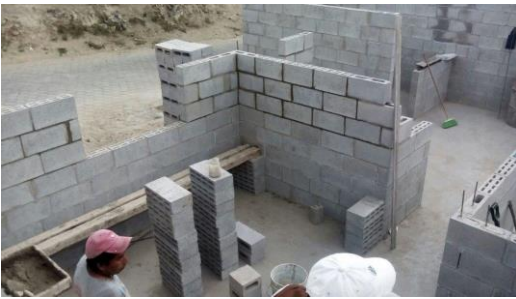
Foto 24, colocación block en muros de acuerdo al secuencial. Fuente: Propia
