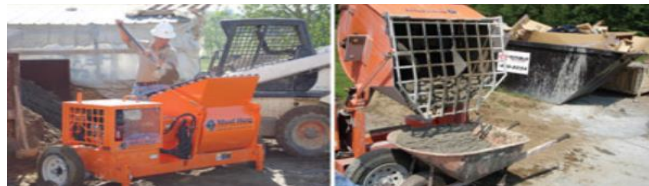
Foto 8, Mezclados por medios mecánicos, Fuente: Propia
