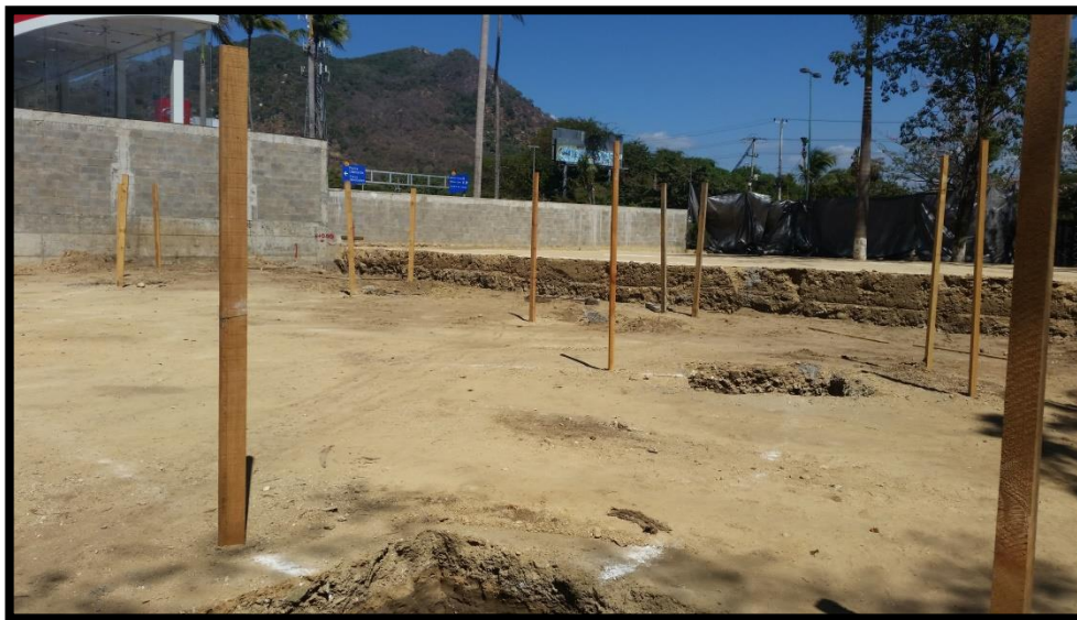
Figura 14.- procedimiento de trazo a puntos de partida de localización
