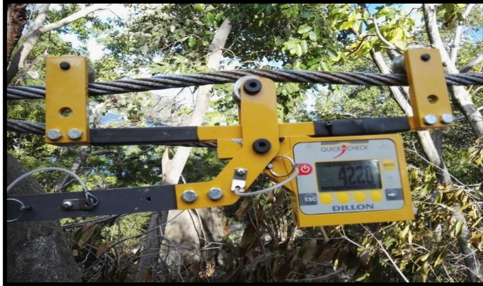
Figura 13.- Tensión y medición de cableado con un instrumento llamado tensiómetro.
