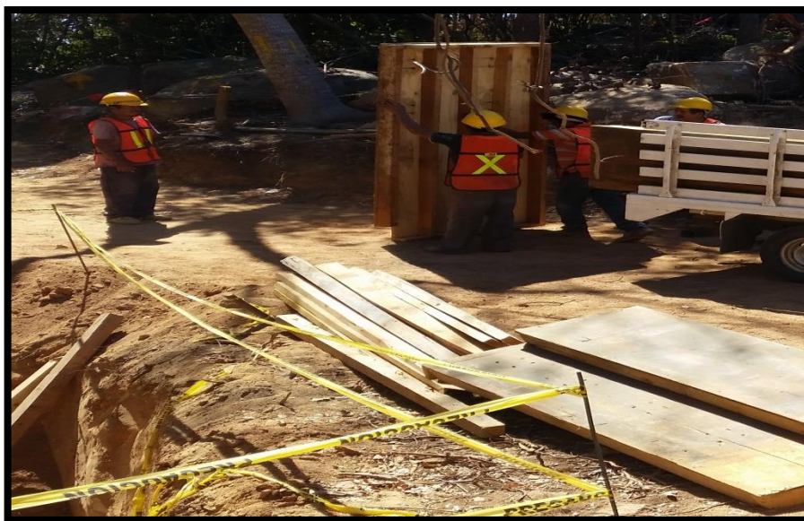
Figura 15.- trazo, corte y habilitado de estacas
