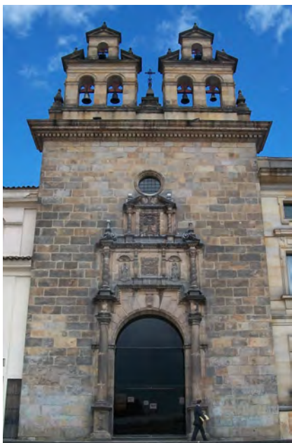
Fig. 7. Vista actual de la fachada de la capilla del Sagrario.
