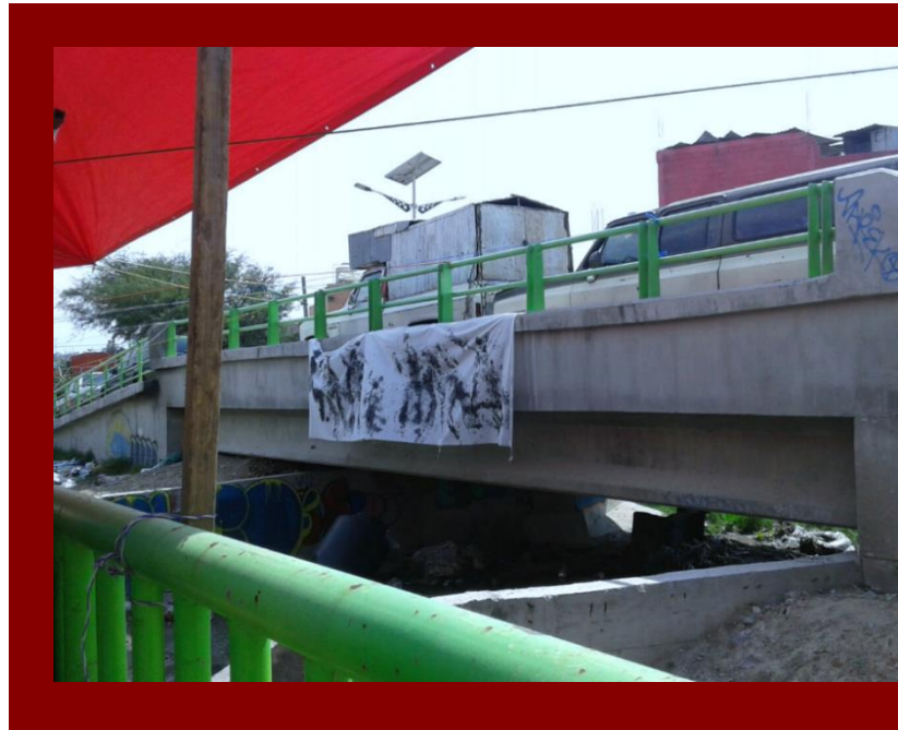
Imagen 50. Intervención de Tapiz sobre puente en Colonia Santa María Tulpetlac, Ecatepec de Morelos, Estado de México (Colocación 20/Mayo/2017).
