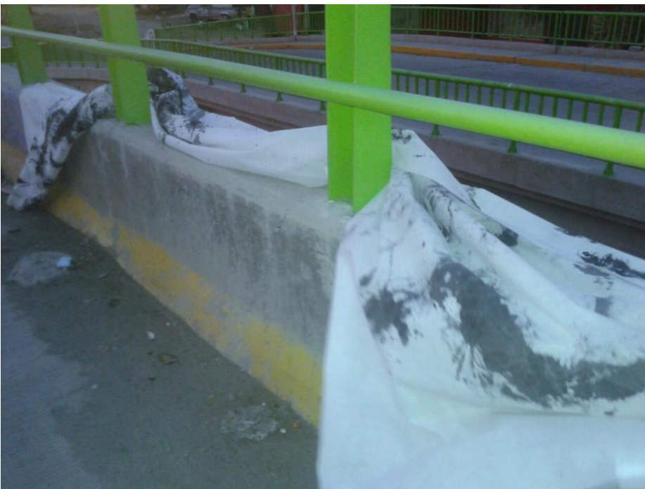
Imagen 52. Intervención de Tapiz, puente en Colonia Santa María Tulpetlac, Ecatepec, Estado de México (Retiro 22/Mayo/2017).
