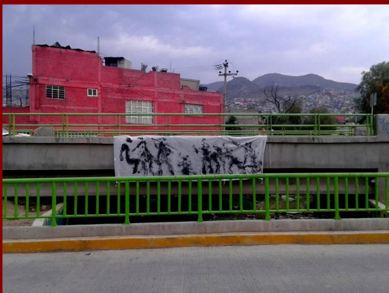
Imagen 49. Intervención de Tapiz sobre puente en Colonia Santa María Tulpetlac, Ecatepec de Morelos, Estado de México (Colocación 20/Mayo/2017).
