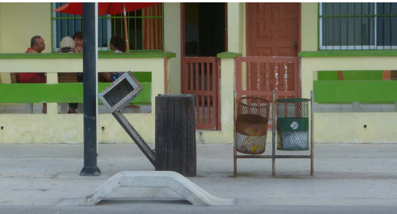
Mobiliario oxidado y dañado, Puerto Progreso, México.
