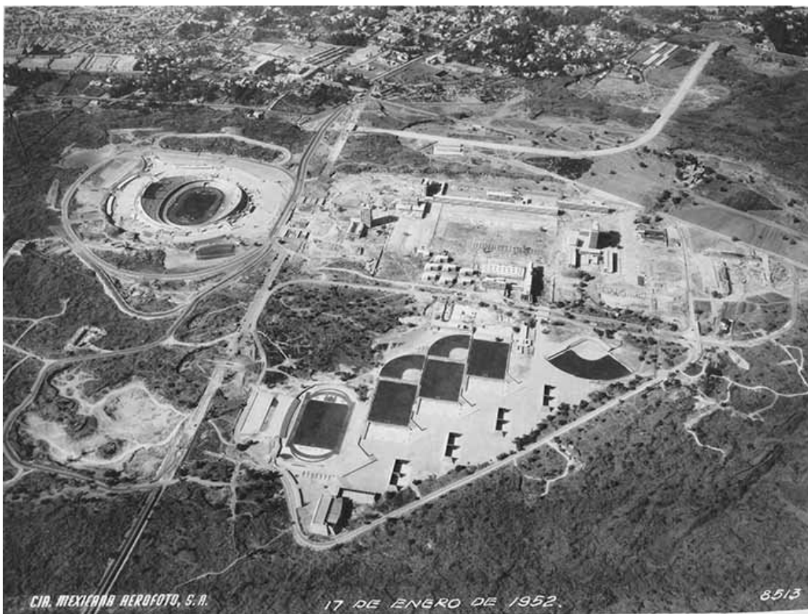
Fotografía aérea del Campus Central de la Universidad durante su construcción, tomada el 17 de enero de 1952 por la Compañía Mexicana Aerofoto. Al noroeste del campus se puede apreciar cierto delineamiento de la zona de Copilco, aunque no había nada construido aún. Fuente: Archivo Histórico de la UNAM, Fondo Colección Universidad, Sección Construcción de CU, Foto CU-0004038
