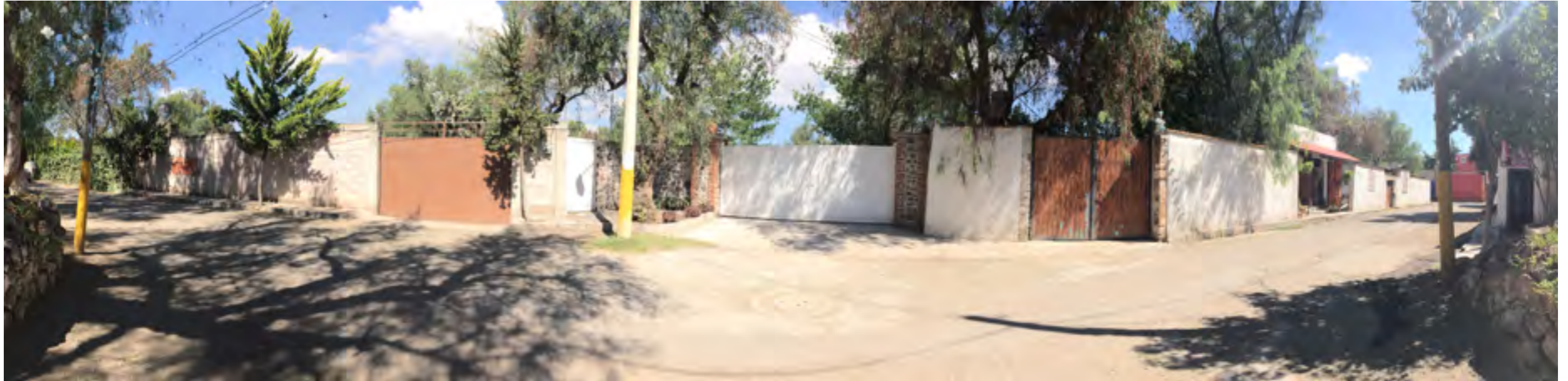
29. Foto 1. Vista Exterior Sur. Acceso principal y calle Tetitla
