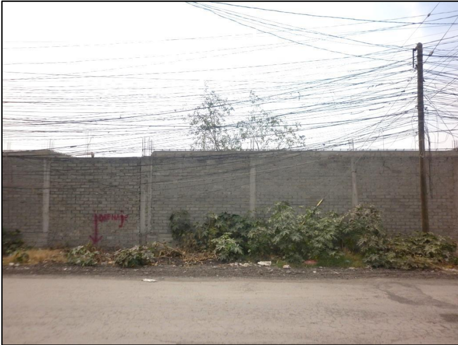
Fuente: Sandra Hidalgo. Asentamiento irregular “Ampliación La Conchita”. Definición de espacios para banqueta e instalación provisional de servicio eléctrico.
