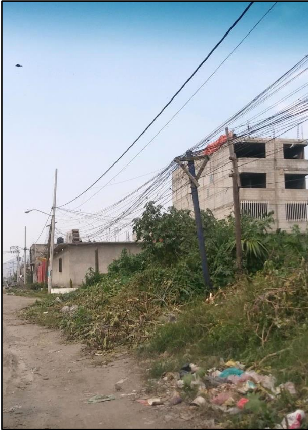
Fuente: Sandra Hidalgo. Asentamiento irregular "Ampliación La Conchita". Construcción de departamentos y servicio provisional de luz.
