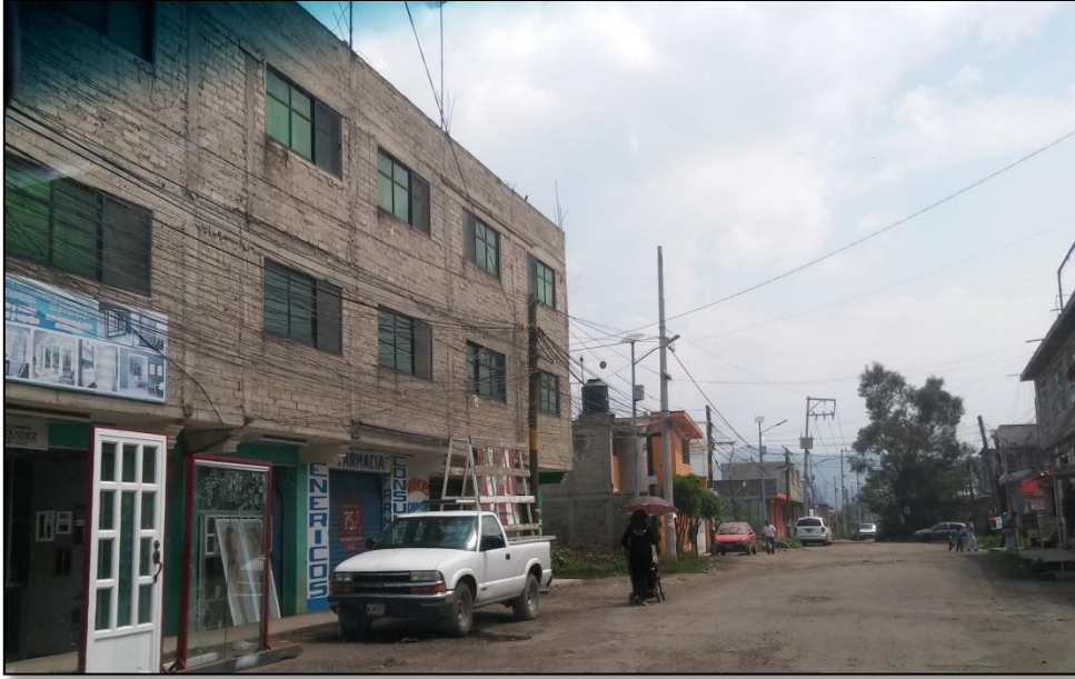
Fuente: Sandra Hidalgo. Asentamiento irregular "Ampliación La Conchita". Departamentos en renta y locales comerciales.
