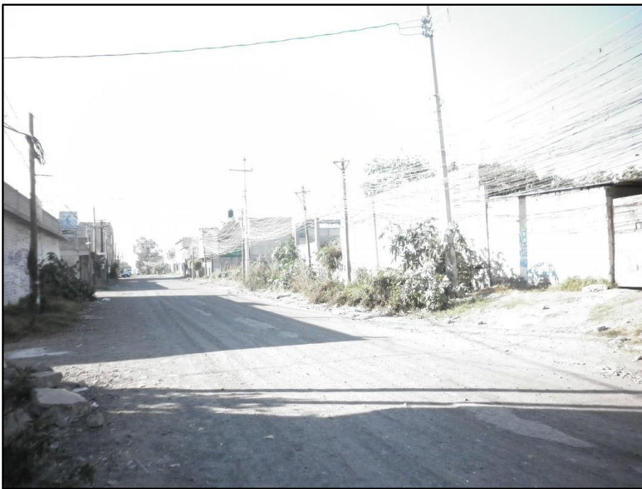
Fuente: Sandra Hidalgo. Asentamiento irregular "Ampliación La Conchita". Definición de espacios para banqueta e instalación provisional de servicio eléctrico.
