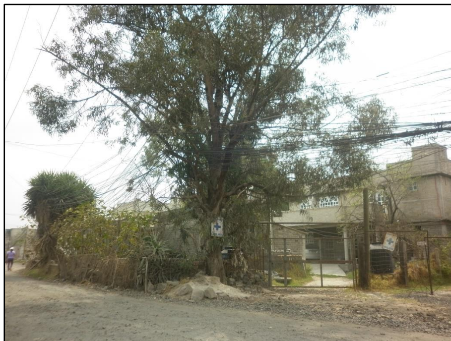
Fuente: Sandra Hidalgo. Asentamiento irregular "Ampliación La Conchita". Instalación provisional de servicio eléctrico.
