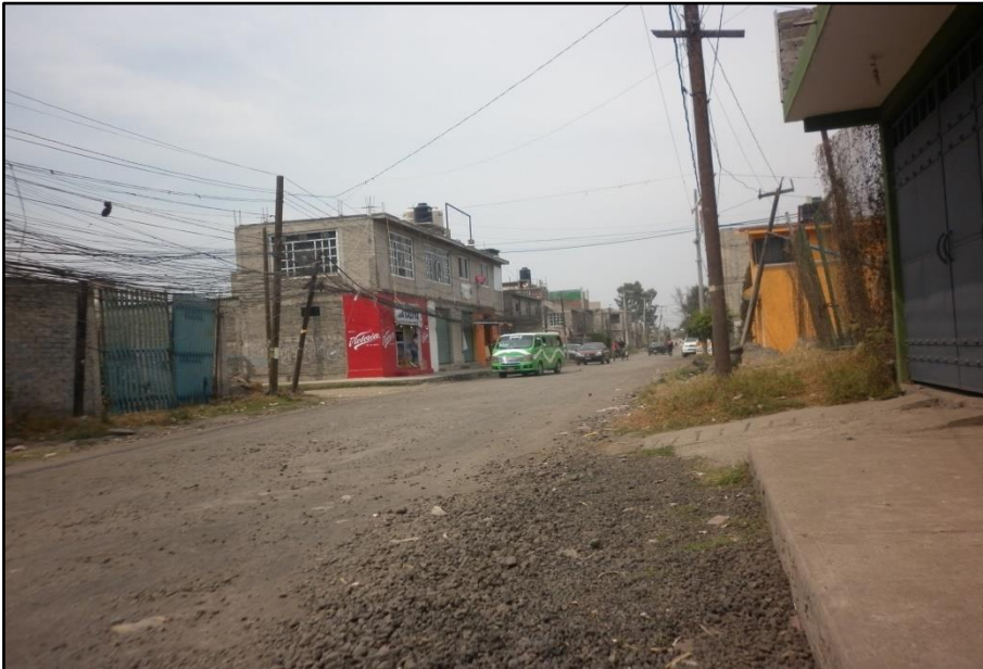
Fuente: Sandra Hidalgo. Asentamiento irregular "Ampliación La Conchita". Estructuración de calle, banqueta y locales de servicio.
