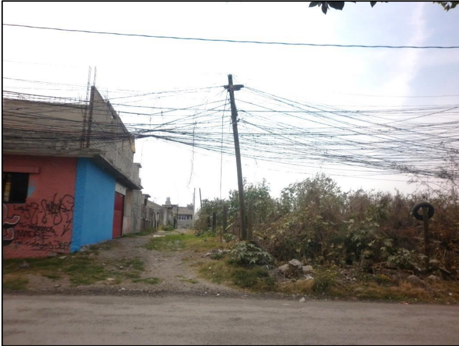
Fuente: Sandra Hidalgo. Asentamiento irregular “Ampliación La Conchita”. Estructuración de calles, espacios para banqueta e instalación provisional de servicio eléctrico.
