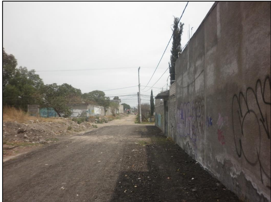
Fuente: Sandra Hidalgo. Asentamiento irregular "Ampliación La Conchita". Estructuración de calle en zona 3.
