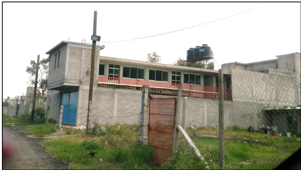
Fuente: Sandra Hidalgo. Asentamiento irregular "Ampliación La Conchita". Construcción de departamentos.
