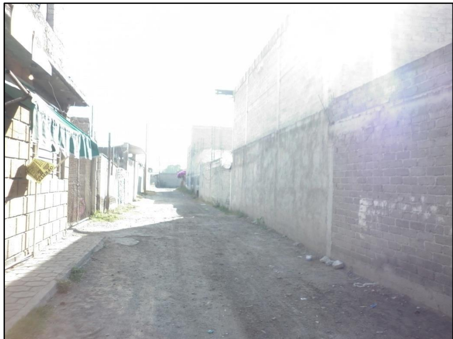
Fuente: Sandra Hidalgo. Asentamiento irregular "Ampliación La Conchita". Estructuración de banquetas y calles.
