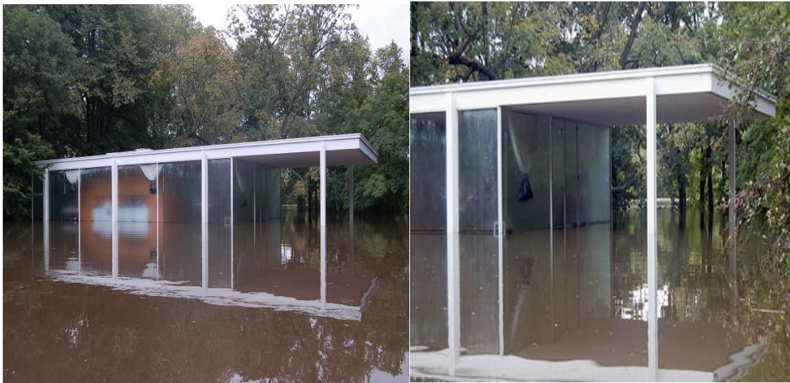
Fig.6.2: Imagen que muestra la inundación de la casa Farnsworth. Obtenida http://www.apartmenttherapy.com/news-mies-van-der-rohes-farnsw-63043 . Recuperado el:24/11/2016
