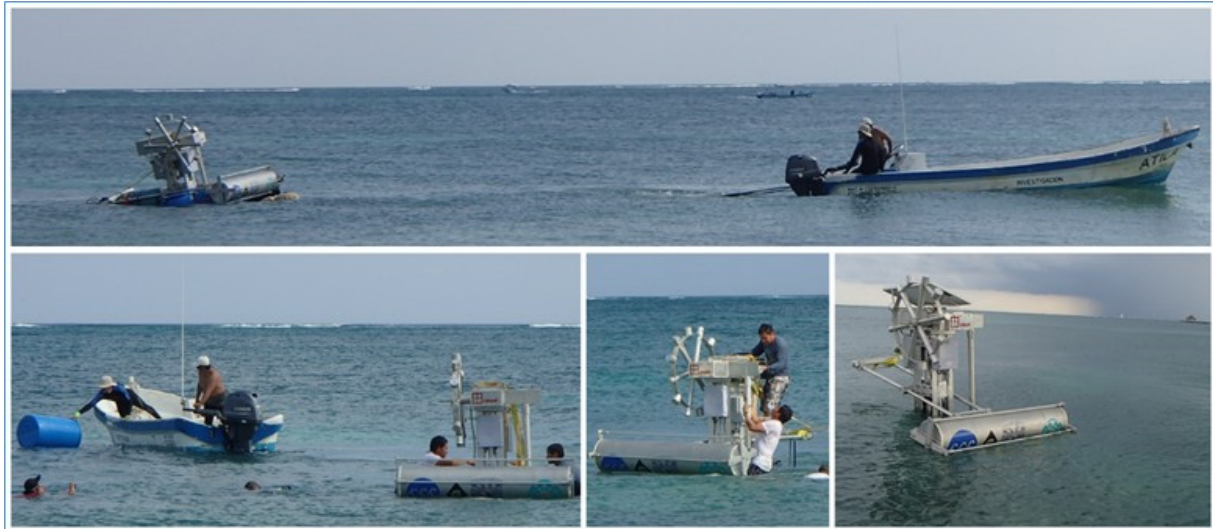
Figura 29.- Instalación y puesta en marcha del WEC MICO-1T en Puerto Morelos
