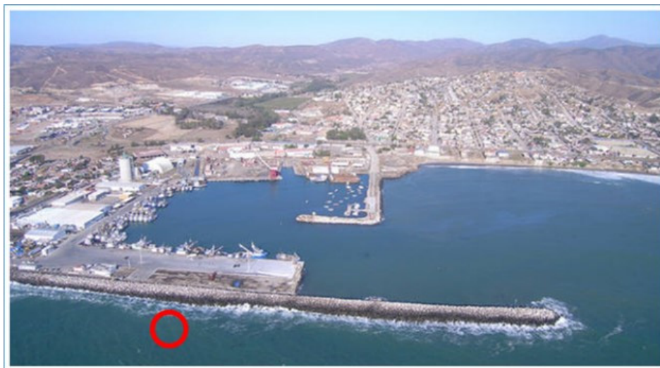
Figura 20.- Sitio propuesto para instalar el modelo 1:1 del WEC DINA-EF, Puerto el Sauzal, Ensenada BC
