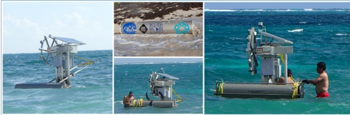
Figura 30.- Reinstalación de la boya en la estructura del WEC
