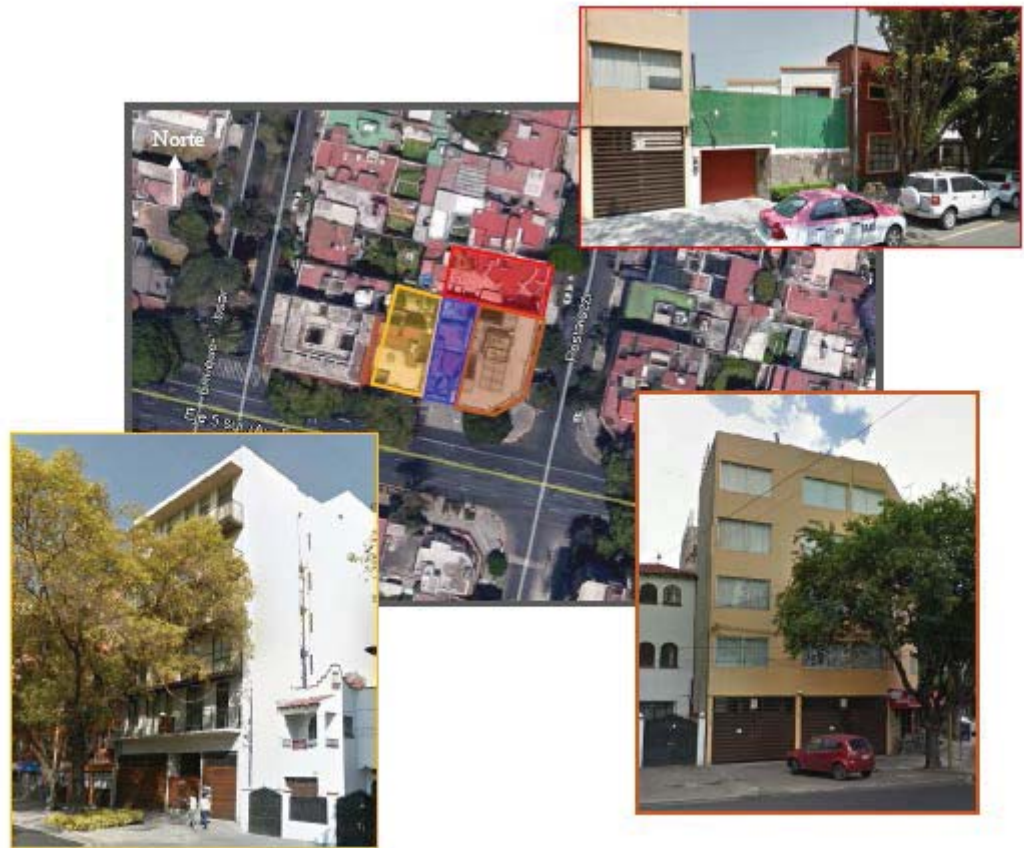
Figura 5. Fachada y colindancias del predio
