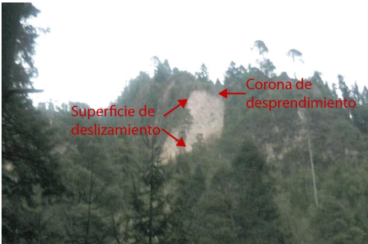
Figura 4.11. Desprendimiento identificado en la ladera E, donde se muestran dos de sus tres componentes: corona de desprendimiento y superficie de deslizamiento.
