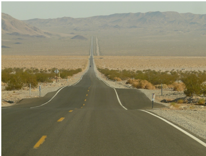
Imagen 19 Camino con ondulaciones generadoras del efecto rebote en el vehículo [15].
