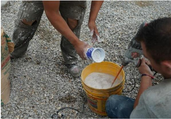
a) Preparación de la lechada, utilizando un mezclador para cemento
