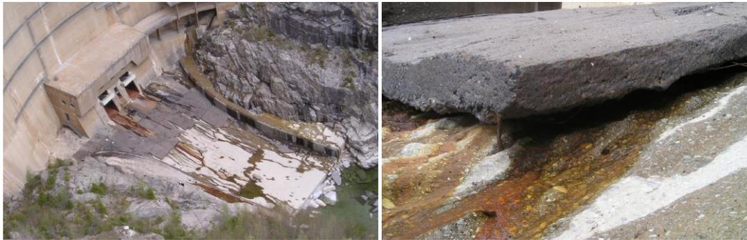
Figura 3.17: Daño en las losas de la Presa Gebidem, Suiza.
