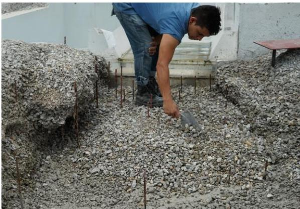
c) Acomodo del agregado grueso en la zona de descarga
