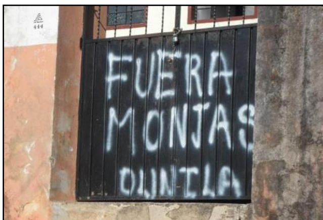
Figura 32. Pinta realizada en la fachada de la Casa Misión de las monjas carmelitas en Olintla
