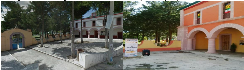
Figura 60. Edificio de gobierno en Santa María Zotoltepec antes y después del remozamiento.
