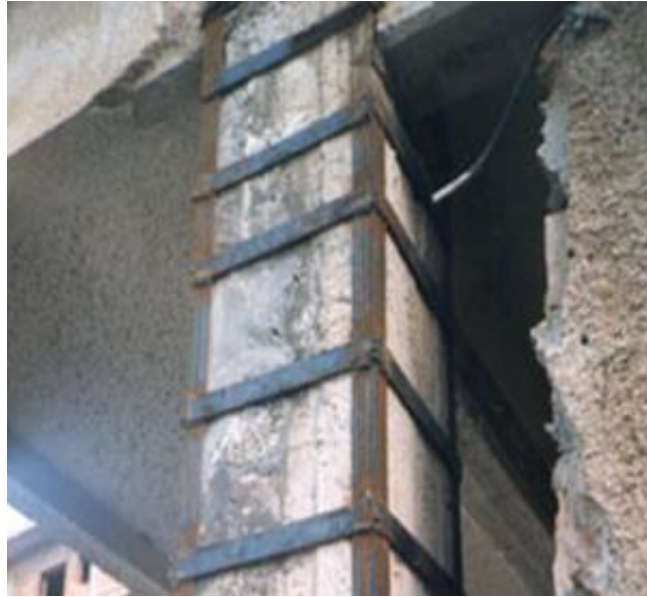
Figura 1.2. Columna reparada con encamisado metálico
