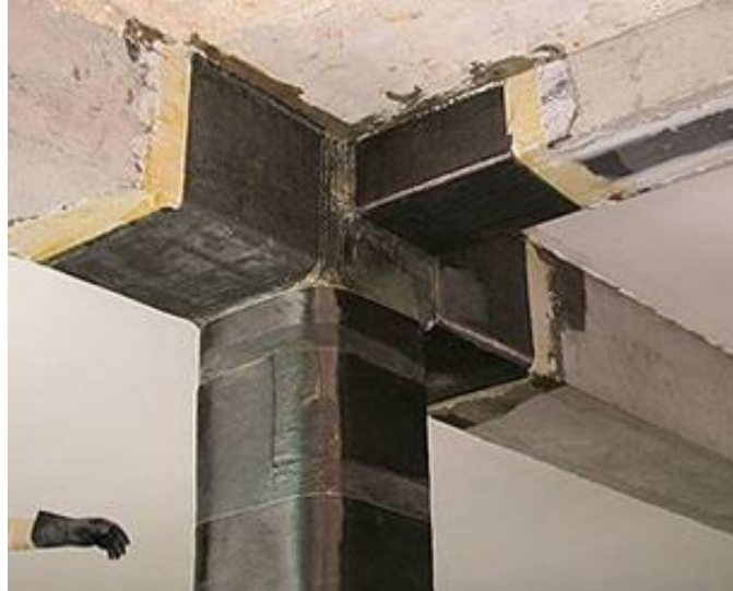
Figura 1.3. Conexión de concreto armado reparada con fibra de carbono
