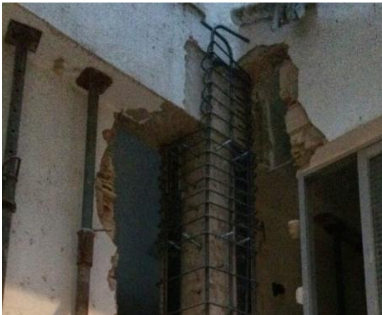
Figura 1.1. Columna con acero de refuerzo para encamisado de concreto
