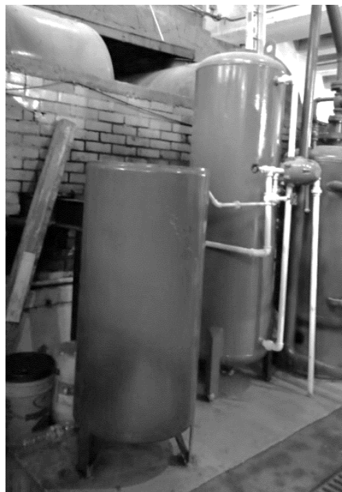
Fotografía 8 a la izquierda dosificador de cloro, a la derecha ablandadores de agua.
