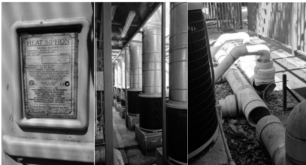
Fotografía 10 Instalación de bombas de calor.
