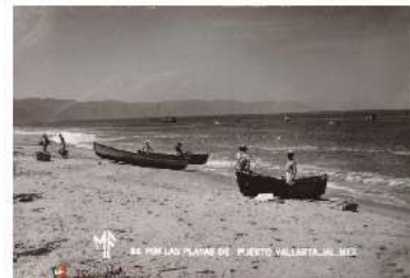
Ilustración 52 Estructura y longitud del malecón en 1950, escenas de la vida cotidiana de los usuarios, plano base H. Ayuntamiento, edición propia.
