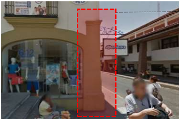
Ilustración 16 Ejemplo de edificación con pilastra que funciona como elemento estructural, colonia centro. Imagen Extraída de googlemaps streetview, 2016, edición propia.
