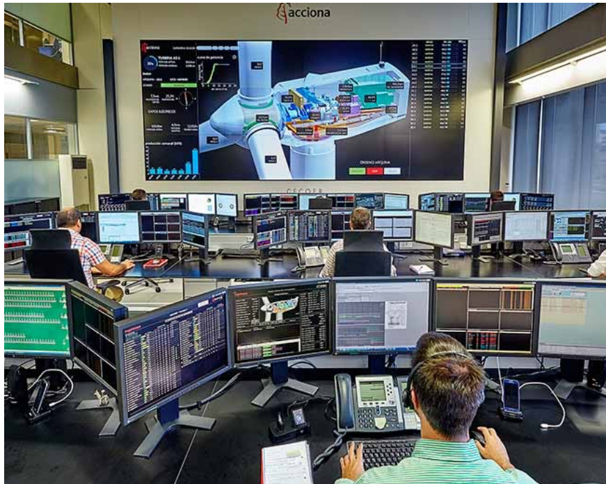
Fotografía 2. Control y operación de un parque eólico desde el CECOER de Acciona Fuente: Acciona, s.f.
