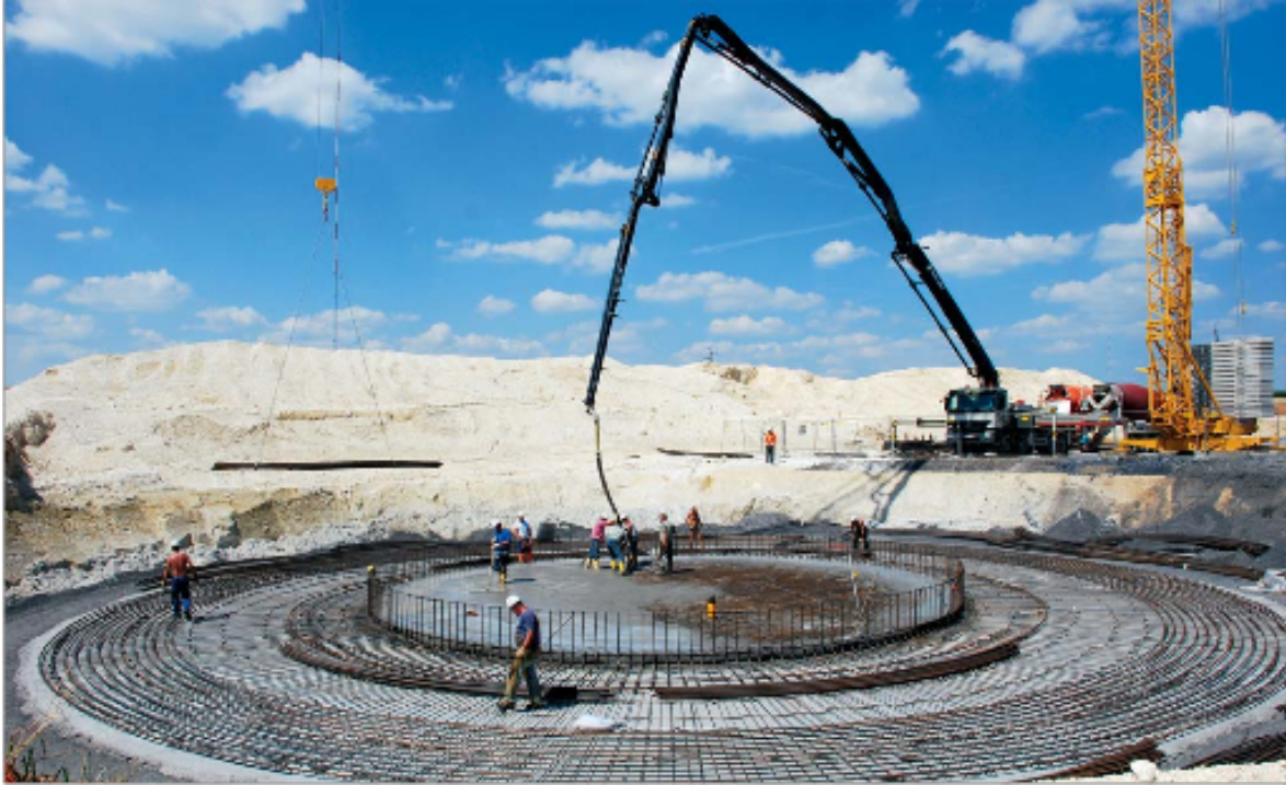
Fotografía 1. Cimentación de un aerogenerador
