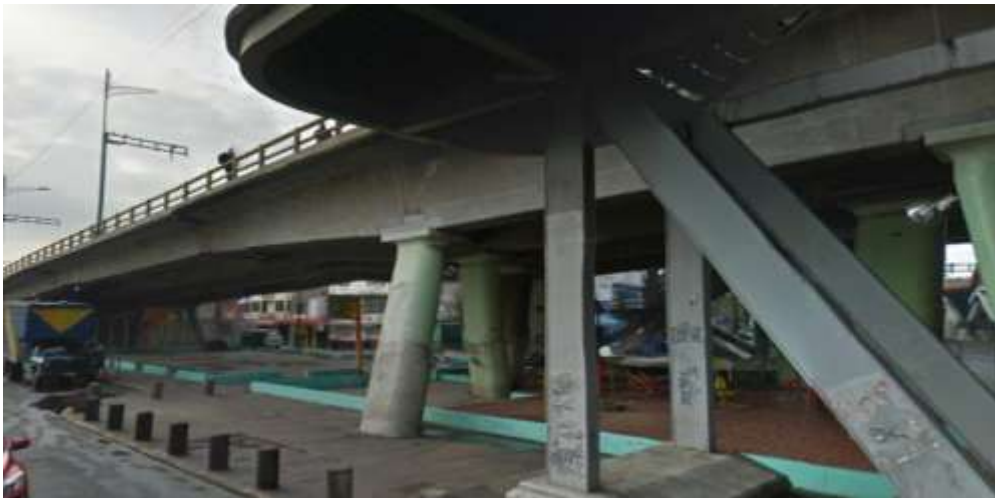
Bajo Puento de Eje 5 Sur Purísima Fuente: Elaboración propia
