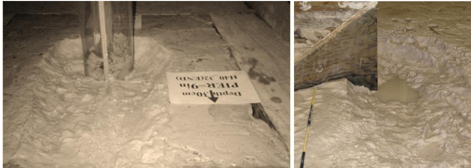
Figura 5.16. Evidencia de desprendimiento de terrones de arcilla por socavación aguas abajo de una pila y estribo de un modelo hidráulico. (Briaud et al, 2009).
