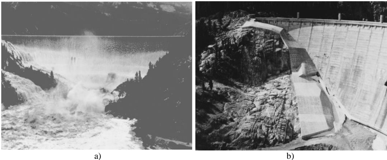
Figura 8.25. Presa de concreto Gibson, Montana: (a) desbordamiento en 1964; (b) modificada para en 1984 para permitir el desbordamiento. (Annandale, 2006)
