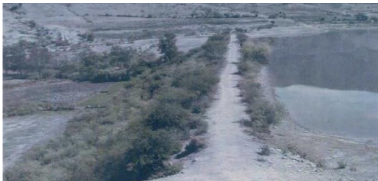
Figura 9.23. Vista de la cortina de la presa con crecimiento de vegetación nativa en su talud aguas abajo.
