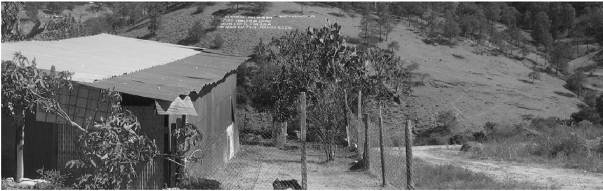
Figura 4.17: Cocina de humo con paredes de lámina de aluminio, este espacio corresponde al plano anterior.
